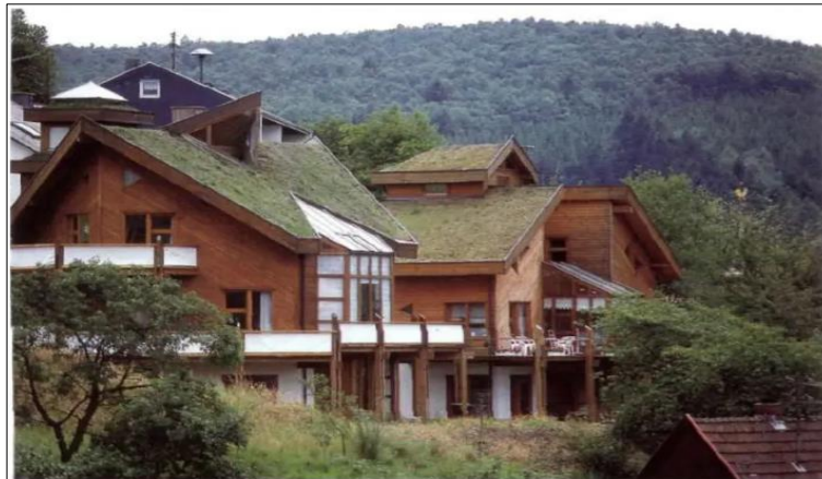
Figura 7: Telhado verde com inclinação de 45° - Siegen Oberscheiden (Alemanha)
