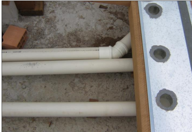
Figura 26: Ligação calha/condutores.
