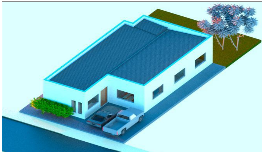
Figura 38: Edificação com telhado embutido de fibrocimento.
