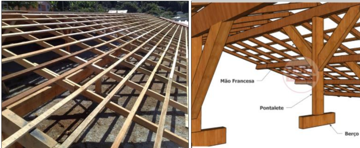
Figura 18: Estrutura pontaletada.
