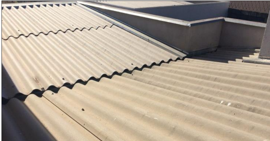
Figura 30: Exemplo de telhado de fibrocimento embutido.
