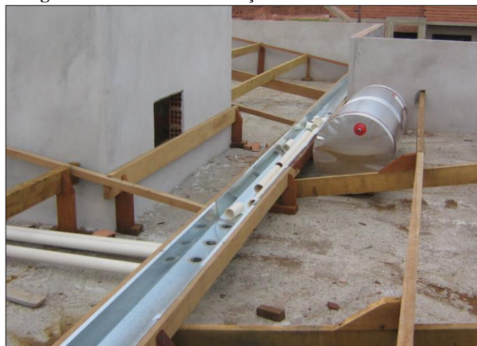
Figura 25: Método de instalação dos condutores na calha.
