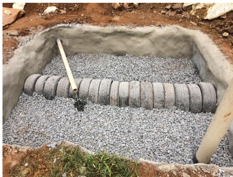
Figura 4.21. Distribuição de brita no fundo do TEVAP. Fonte: Dados de pesquisa.
