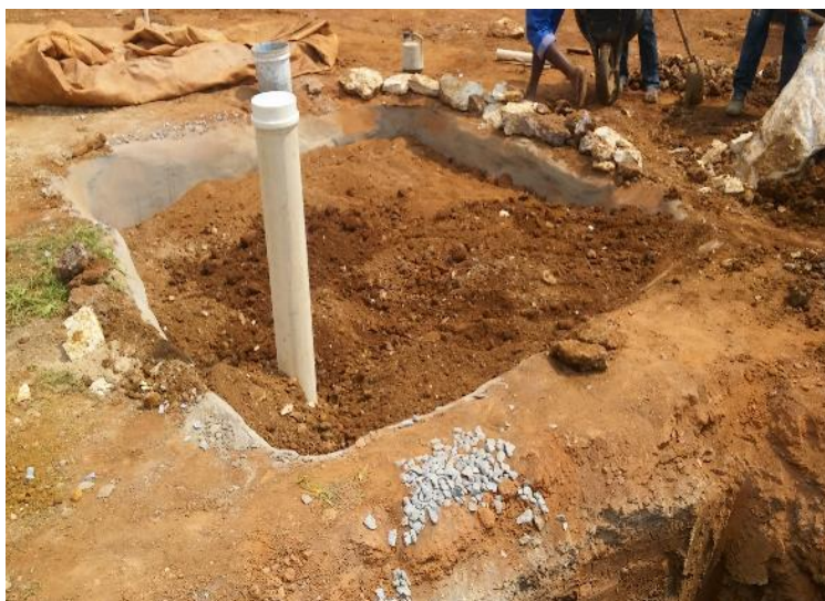
Figura 4.24. Cobertura do TEVAP com solo. Fonte: Dados de pesquisa.
