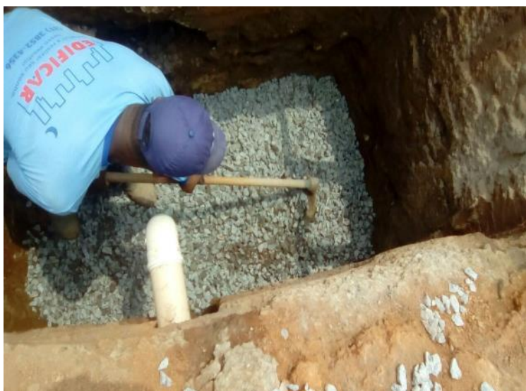
Figura 4.25. Distribuição de brita no fundo do sumidouro. Fonte: Dados de pesquisa.
