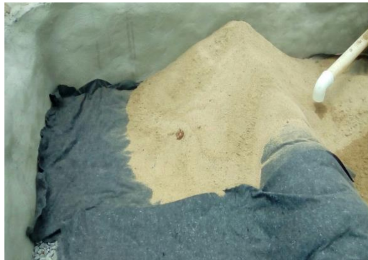
Figura 4.23. Distribuição de areia sobre a manta geotêxtil. Fonte: Dados de pesquisa.
