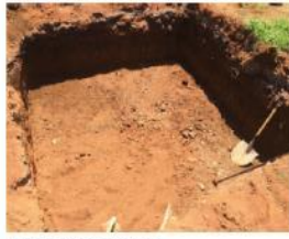
Figura 8. Preparação do TEVAP. Fonte: LOPES, 2018.
