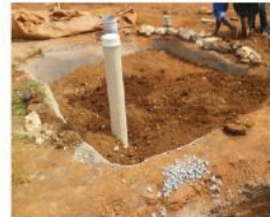
Figura 15. Cobertura do TEVAP com solo. Fonte: LOPES, 2018.
