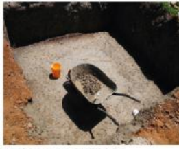
Figura 9. Construção do piso do TEVAP. Fonte: LOPES, 2018.
