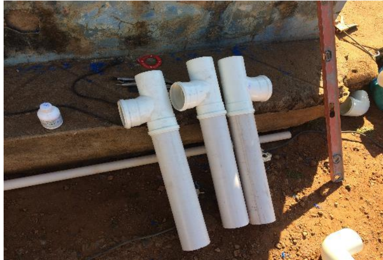
Figura 4.12. Preparação das tubulações do TSE. Fonte: Dados de pesquisa.
