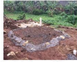
Figura 17. Finalização da construção do TEVAP. Fonte: LOPES, 2018.
