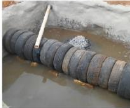
Figura 11. Distribuição de pneus no interior do TEVAP. Fonte: LOPES, 2018.
