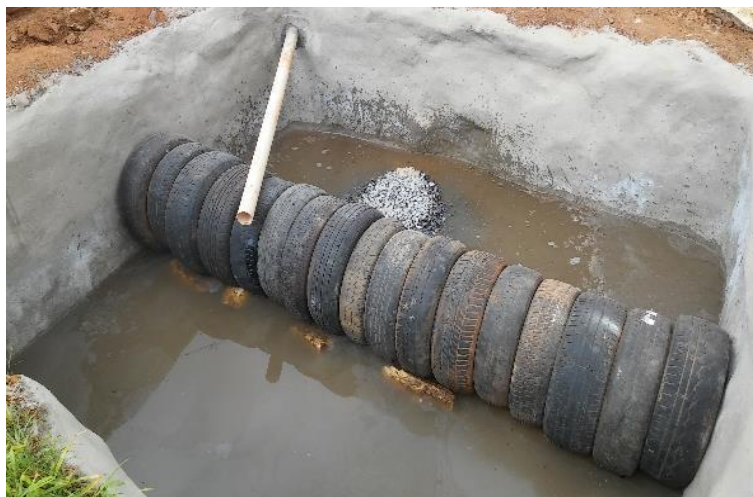
Figura 4.19. Distribuição de pneus no interior do TEVAP. Fonte: Dados de pesquisa.
