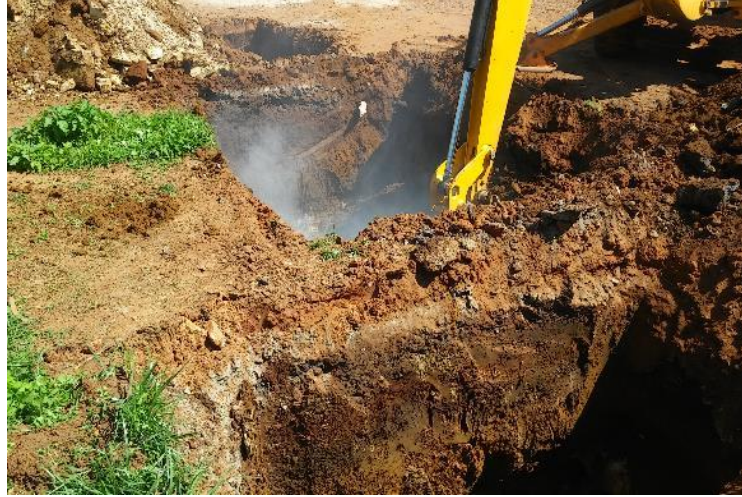
Figura 4.10. Escavação do terreno. Fonte: Dados de pesquisa.
