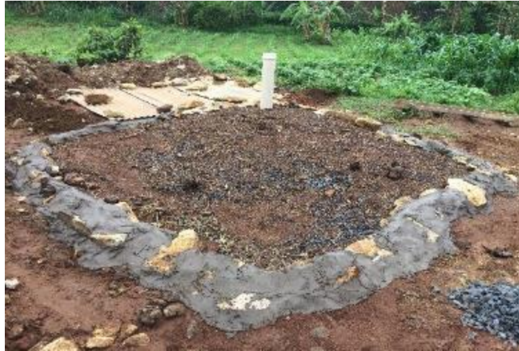
Figura 4.26. Finalização da construção do TEVAP. Fonte: Dados de pesquisa.
