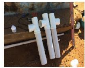
Figura 3. Preparação das tubulações do TSE. Fonte: LOPES, 2018.
