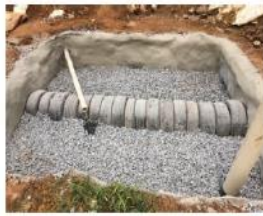
Figura 12. Distribuição de brita no fundo do TEVAP. Fonte: LOPES, 2018.
