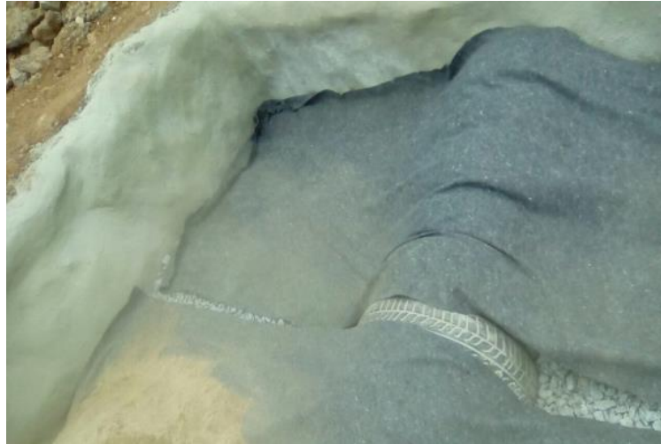
Figura 4.22. Cobertura do TEVAP com manta geotêxtil. Fonte: Dados de pesquisa.
