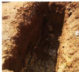
Figura 1. Abertura de vala para o TSE. Fonte: LOPES, 2018.
