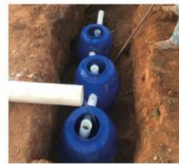
Figura 4. Montagem do TSE. Fonte: LOPES, 2018.
