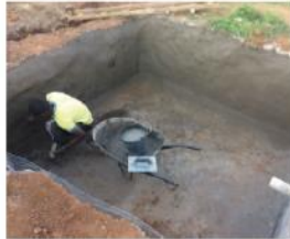
Figura 10. Impermeabilização do TEVAP. Fonte: LOPES, 2018.
