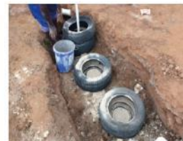
Figura 6. Cobertura do TSE. Fonte: LOPES, 2018.
