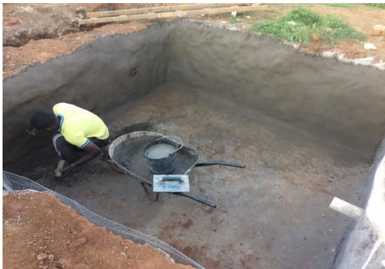
Figura 4.18. Impermeabilização do TEVAP. Fonte: Dados de pesquisa.
