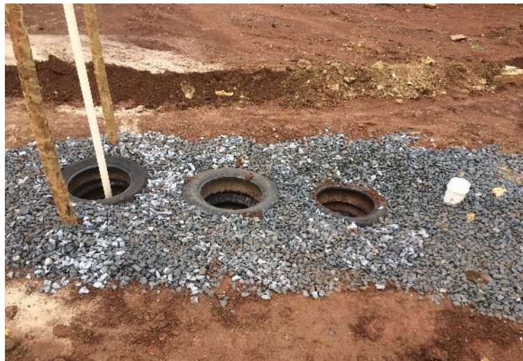
Figura 4.27. Contenção de brita ao redor do TSE. Fonte: Dados de pesquisa.
