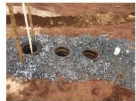
Figura 7. Contenção de brita ao redor do TSE. Fonte: LOPES, 2018.
