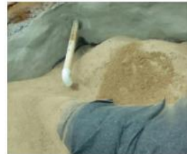
Figura 14. Distribuição de areia sobre as mantas geotêxtil. Fonte: LOPES, 2018.
