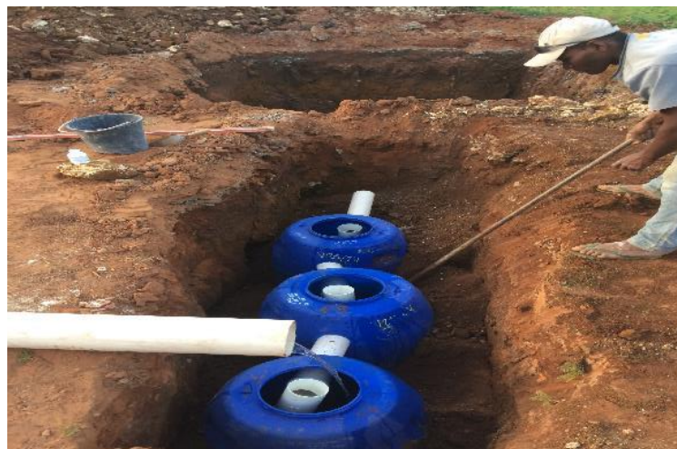
Figura 4.13. Montagem do TSE. Fonte: Dados de pesquisa.
