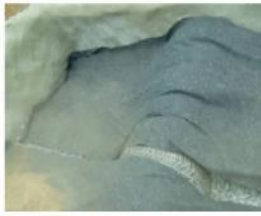
Figura 13. Cobertura do TEVAP com manta geotêxtil. Fonte: LOPES, 2018.
