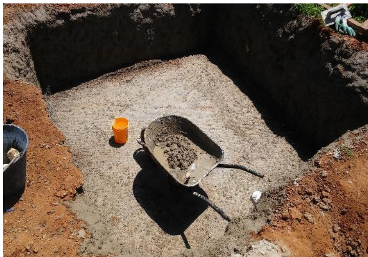
Figura 4.17. Construção do piso do TEVAP. Fonte: Dados de pesquisa.
