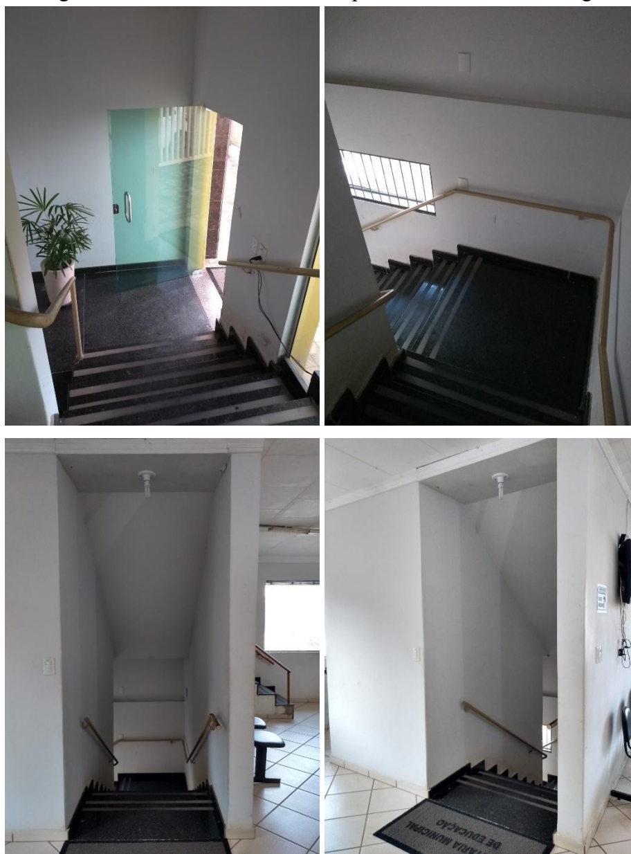
Figura 16 - Escada de acesso ao 1º pavimento do Prédio Antigo
