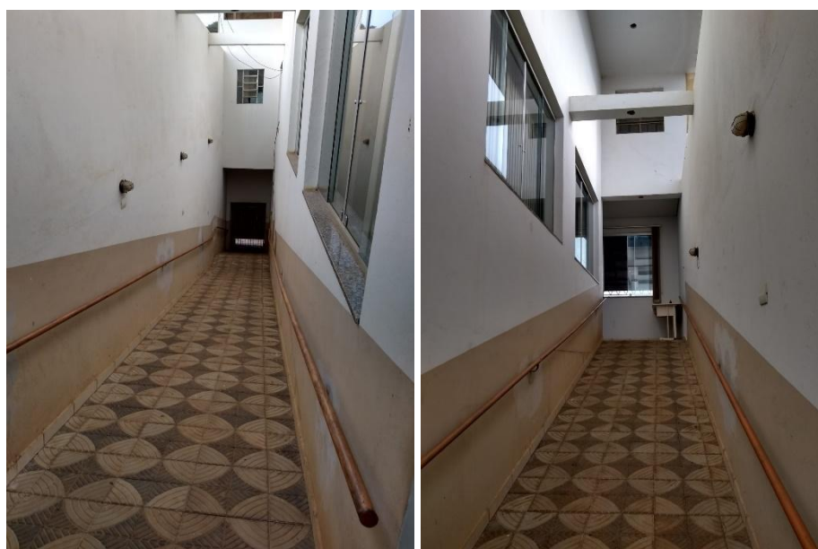
Figura 13 - Rampa de acesso à saída para via pública
