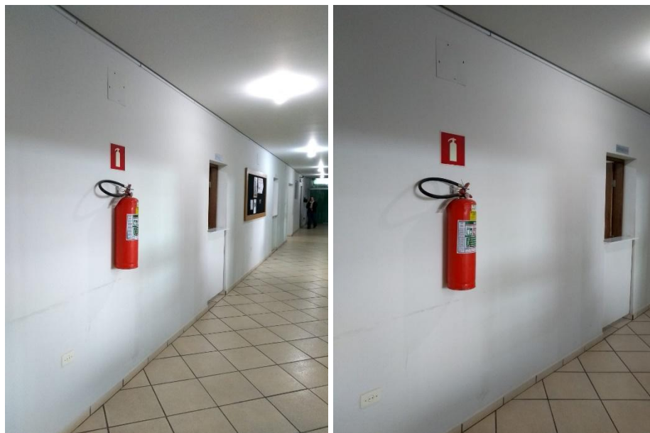
Figura 9 - Corredor do térreo do Prédio Antigo
