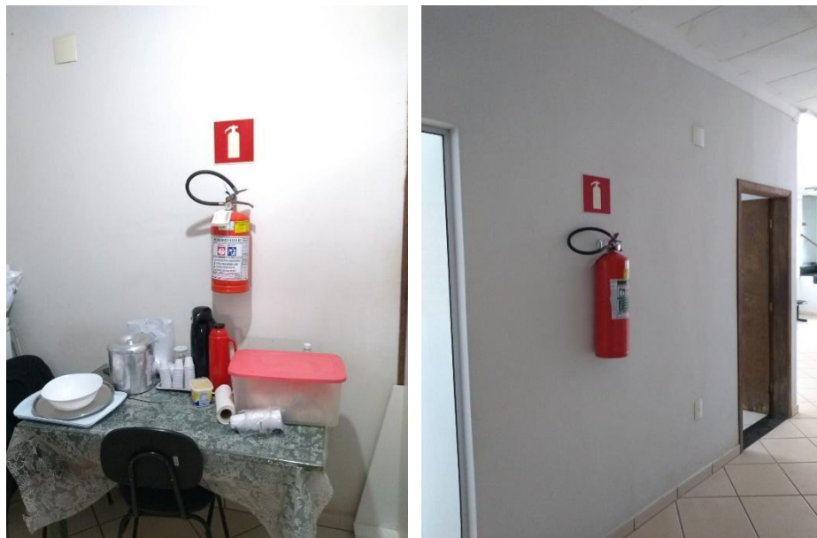
Figura 15 - Corredor do 1º pavimento do Prédio Antigo
