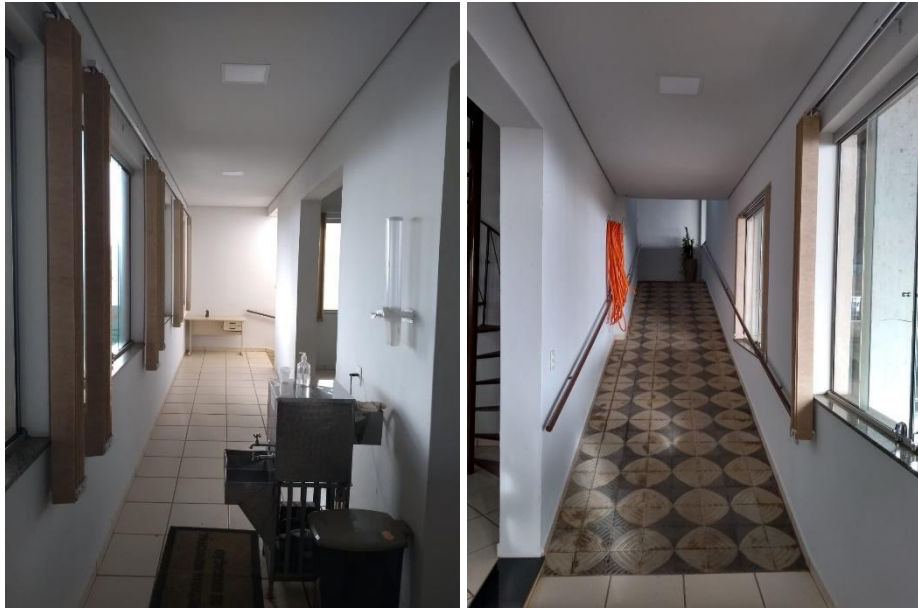
Figura 14 - Corredor e rampa de acesso ao 1º pavimento do Prédio Antigo
