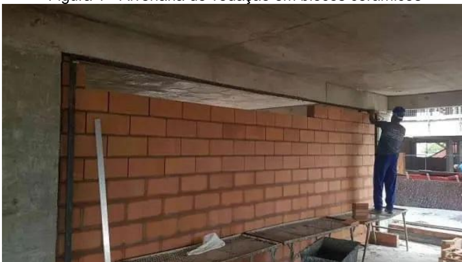
Figura 1 - Alvenaria de vedação em blocos cerâmicos
