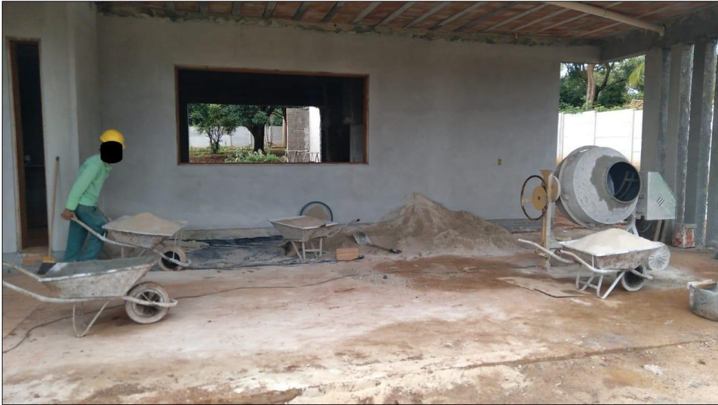
Figura 21 - Trabalhador utilizando EPI's e ambiente de trabalho organizado
