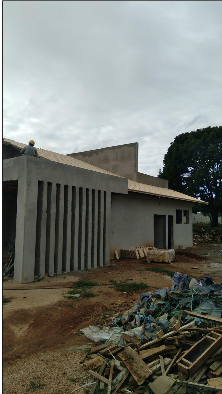
Figura 22 - Trabalhador executando trabalhos em altura e área destinada a entulhos
