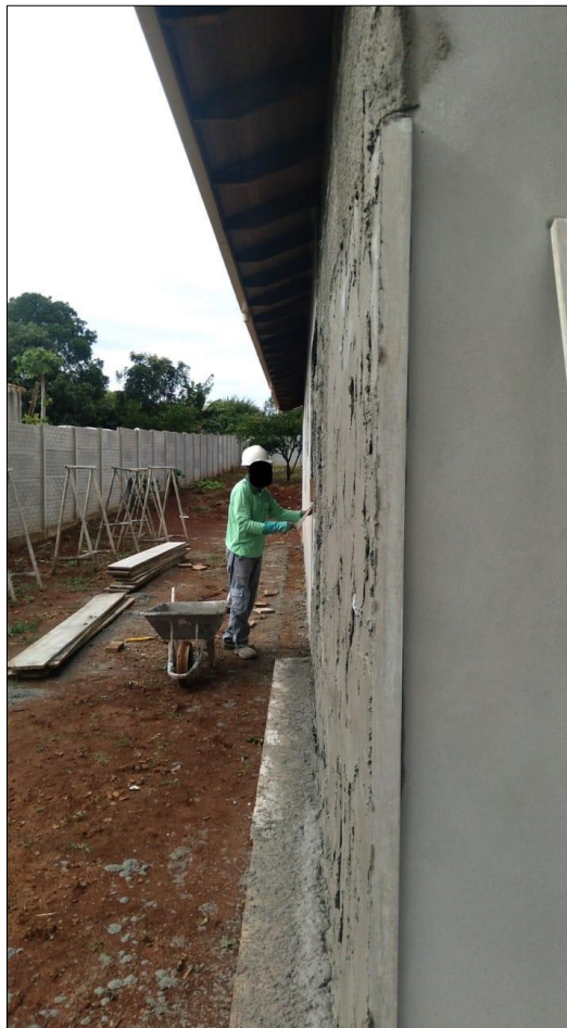
Figura 20 - Trabalhador executando serviços com utilização de EPI's
