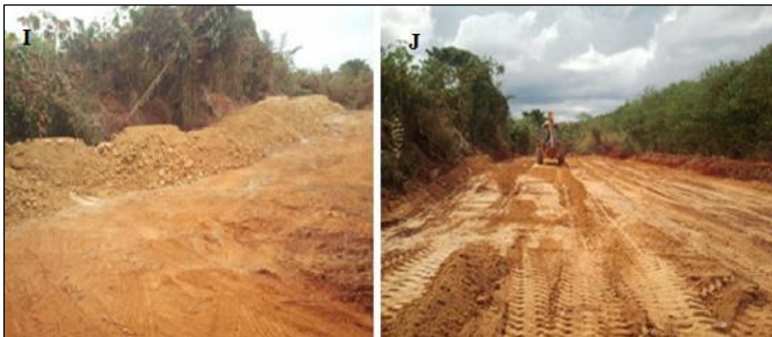
Figura 81 - Continuação do Aterramento e Nivelamento do Terreno.
