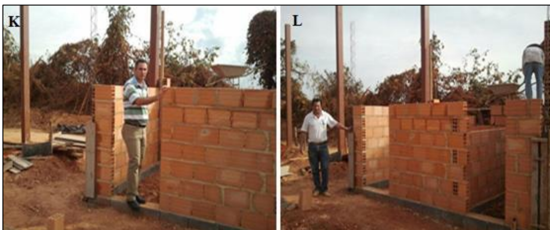
Figura 82 - Construção do Escritório e Banheiro. À esquerda Valdeci (mestrando); Direita (Nilton – parceiro, representante do IMA)
