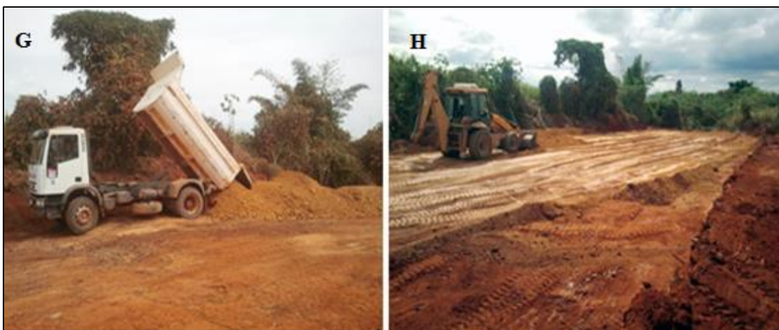
Figura 80 - Aterramento e Nivelamento do Terreno.
