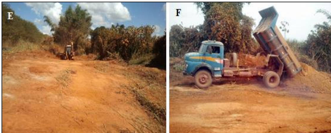
Figura 79 - Continuação da Limpeza e Aterramento do Terreno
