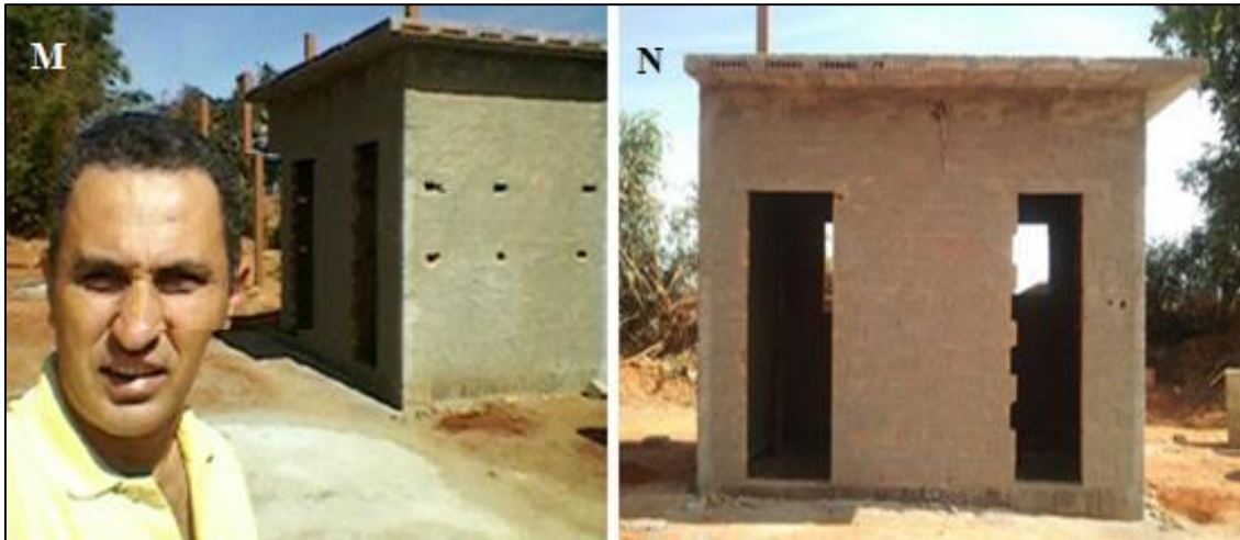
Figura 83 - Continuação da Construção do Escritório e Banheiro. Valdeci (mestrando)
