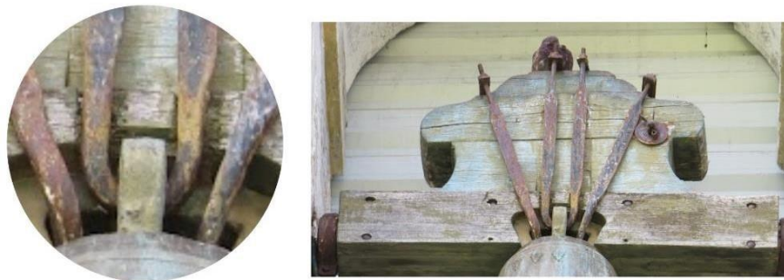
Figura 15: Detalhe dos suspensórios presos à coroa. Fonte: Marília Sinimbú, 2023.
