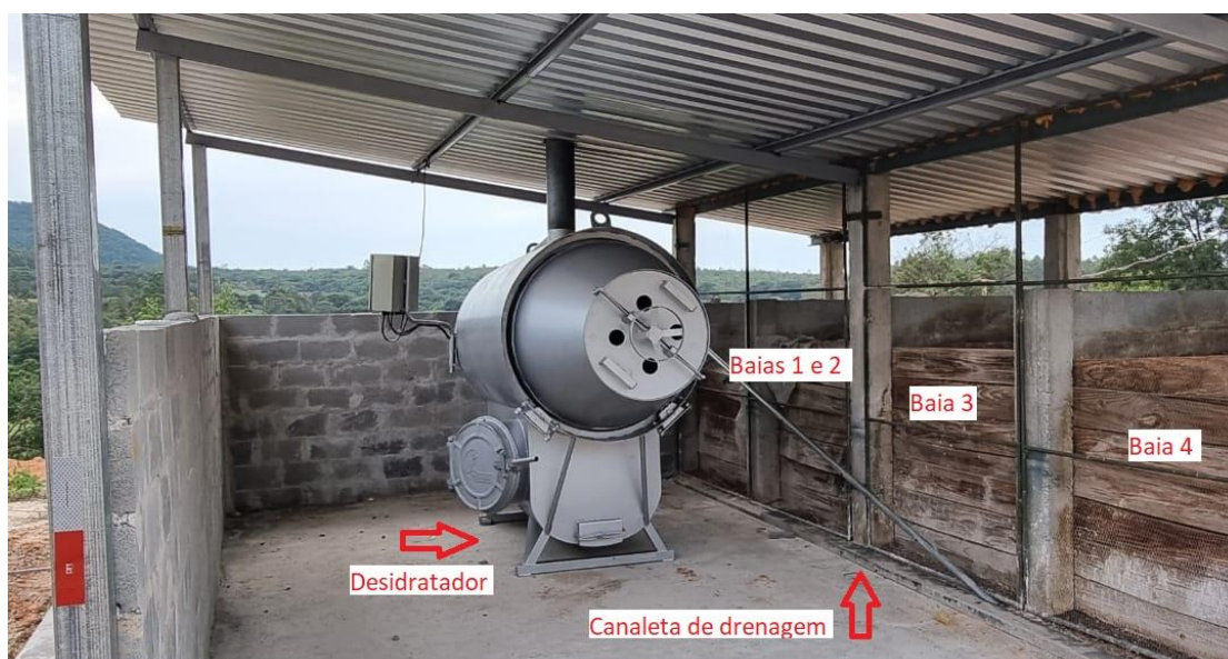
Figura 3 – Desidratador e composteira
