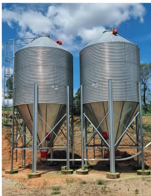
Figura 7 – Silos para armazenamento de ração
