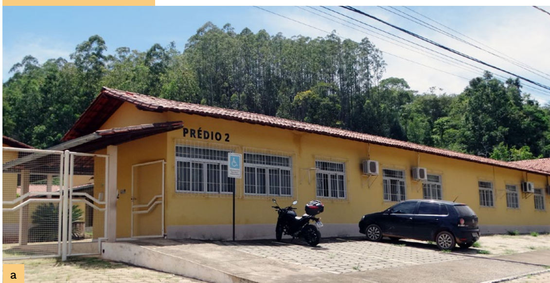
Figura 30 . Prédio 2: fachada (a), pátio interno (b).
