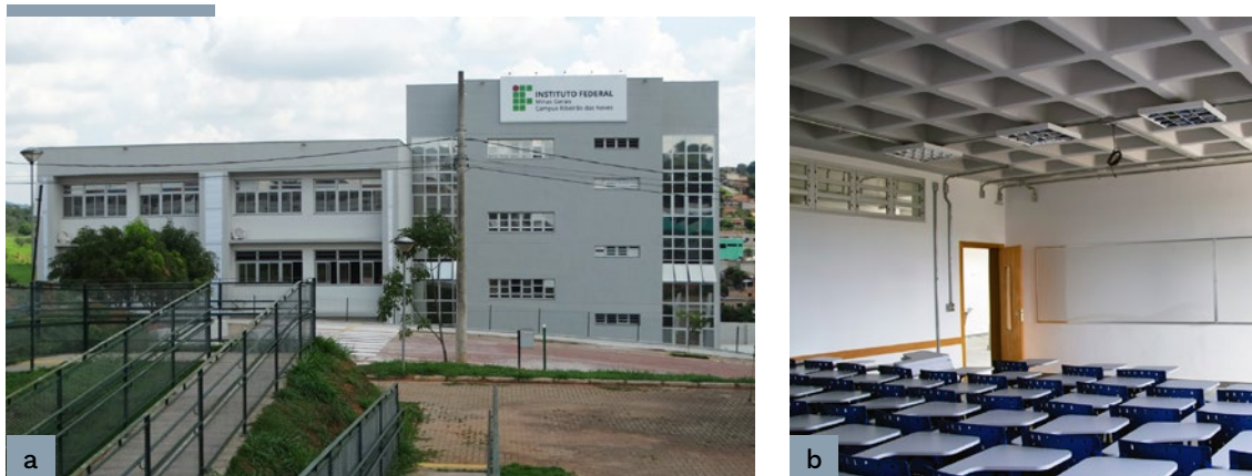
Figura 72 . Novo Bloco Didático (a), sala de aula (b).
