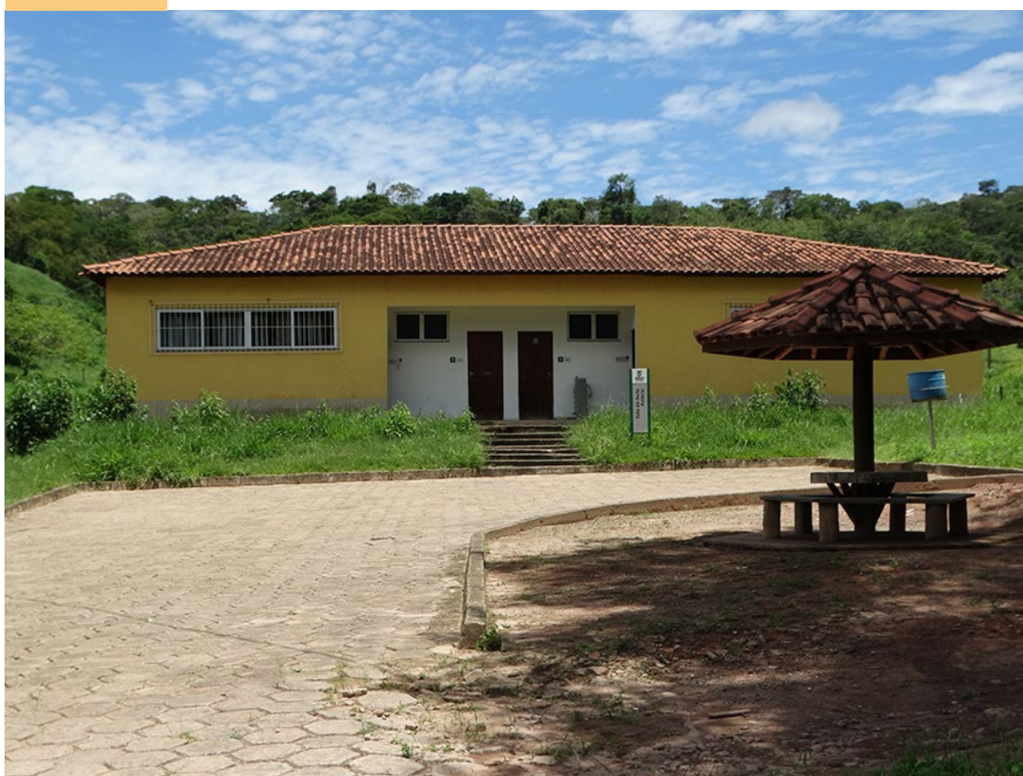
Figura 41 . Sala de aula isolada.
