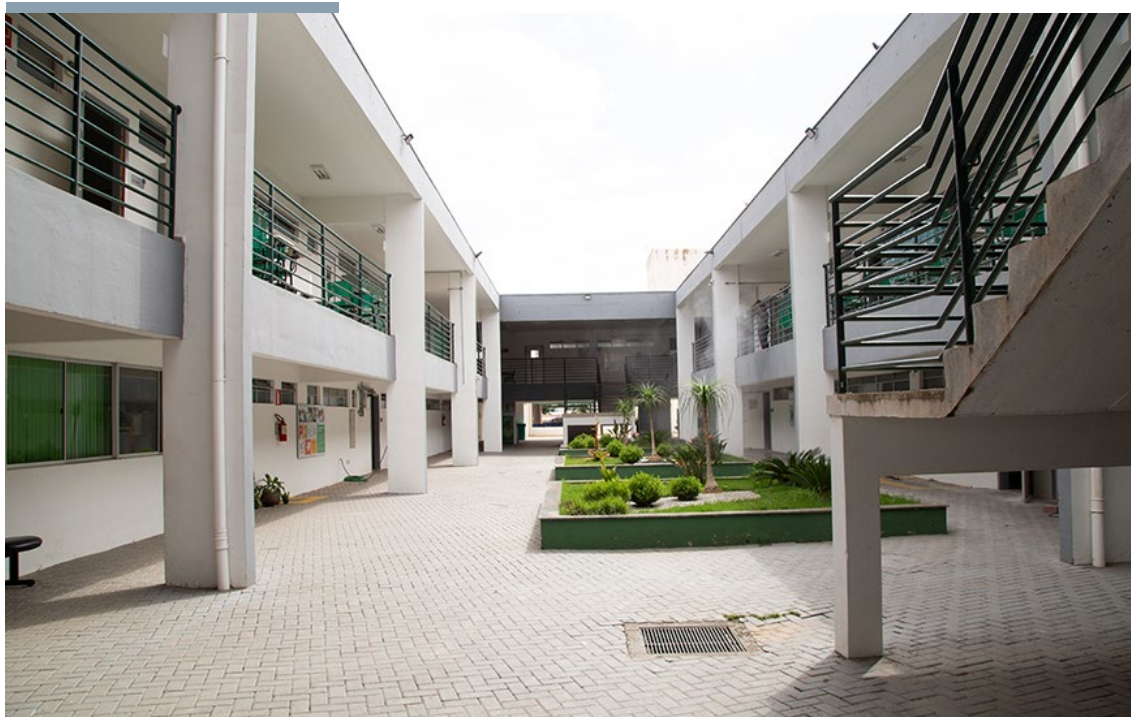
Figura 63 . Bloco Pedagógico, Campus Ribeirão das Neves – pátio interno.
