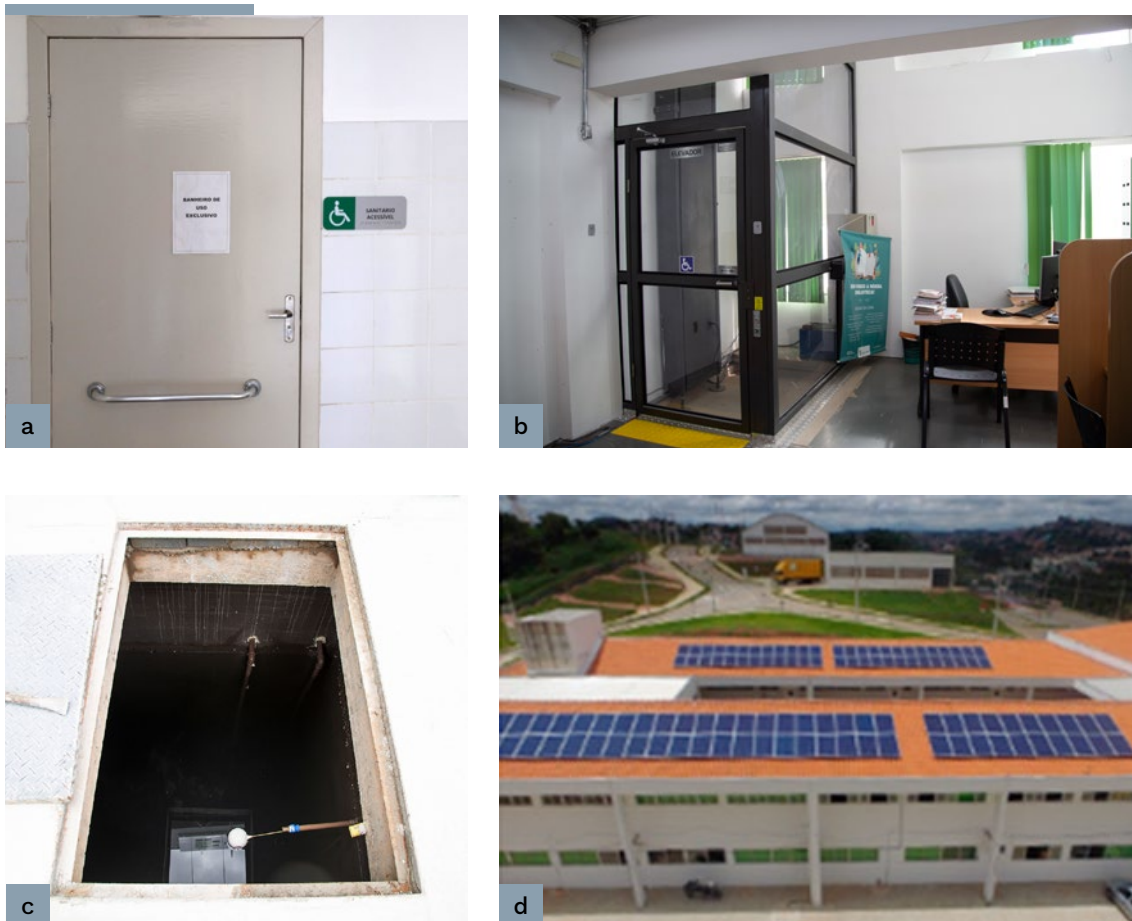
Figura 74 . Elementos de acessibilidade e sustentabilidade: (a) sanitário acessível; (b) elevador (c) caixa coletora de águas pluviais; (d) placas fotovoltaicas.
