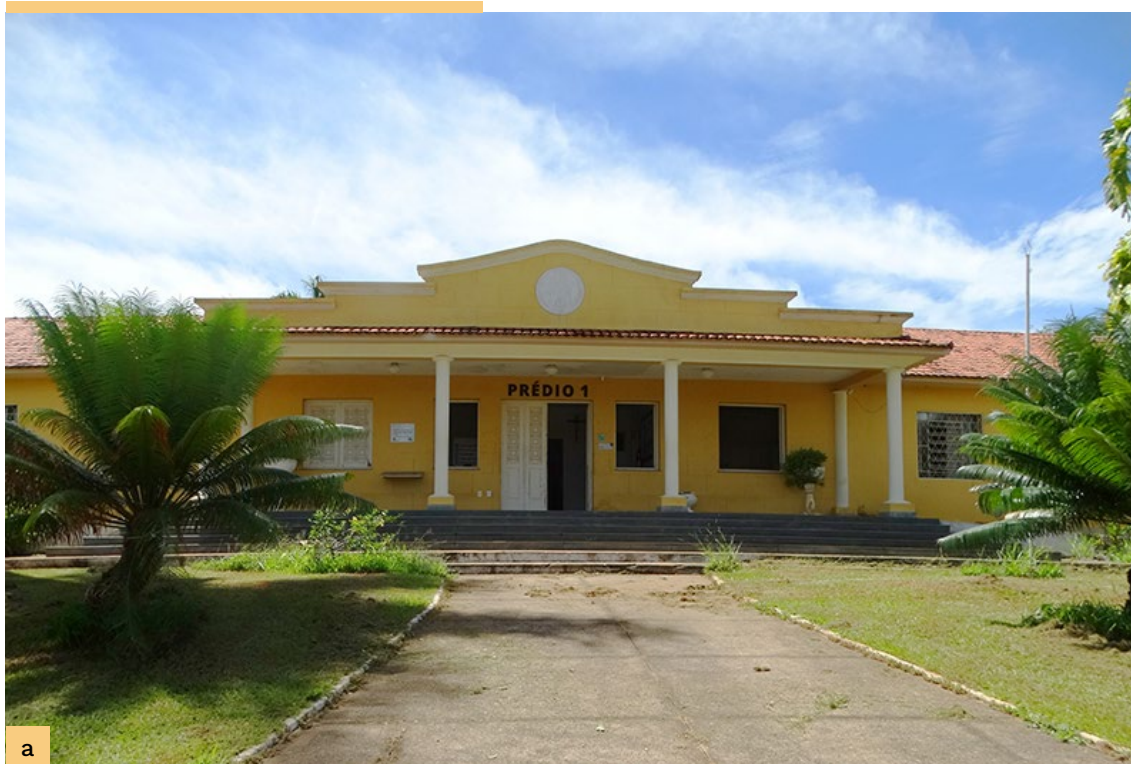
Figura 22 . Prédio 1: (a) fachada principal; (b) mapa de localização; (c) pátio interno.
