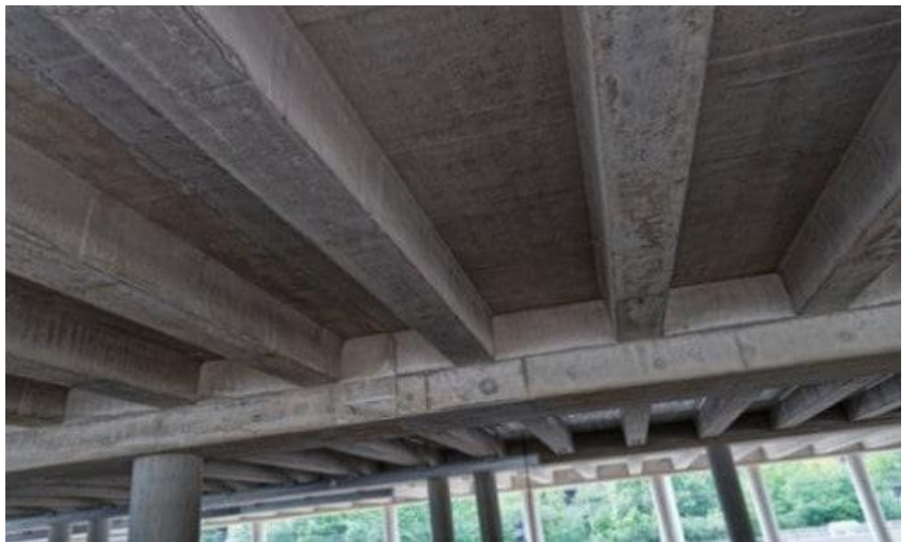
Figura 6 - Laje nervurada concretada “ in loco ”
