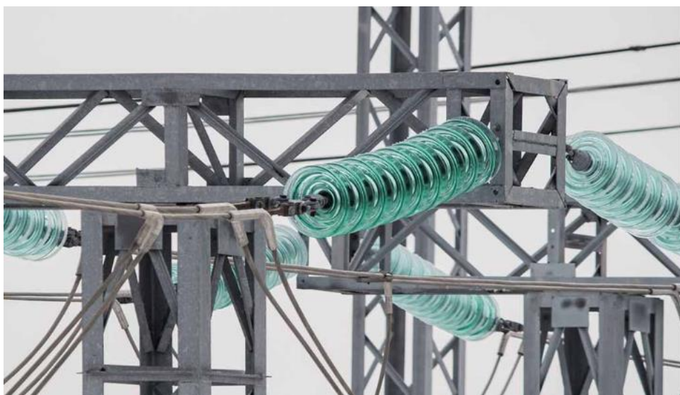
Figura 9 – Isoladores de suspensão em forma de disco.
