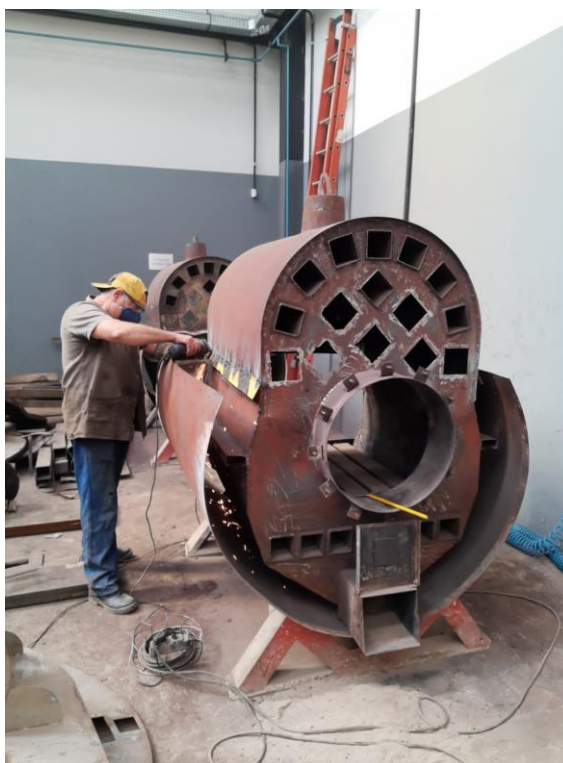
Figura 5.5 – Processo de desmontagem do aquecedor
