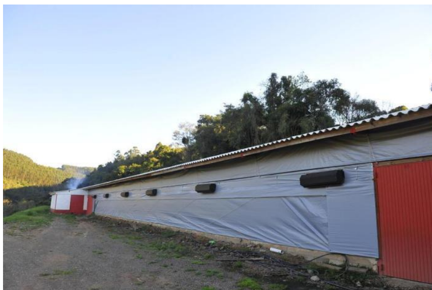
Figura 4.8 – Área externa de um aviário dark house .
