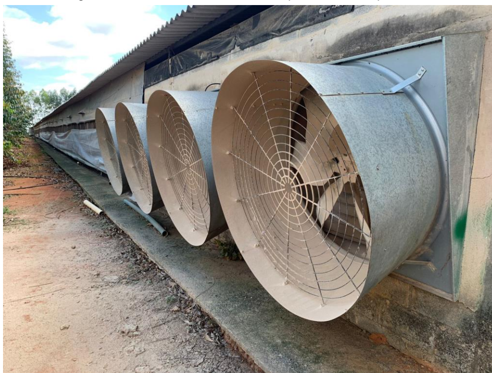
Figura 4.11 – Exaustores axiais com pás inclinadas para trás.
