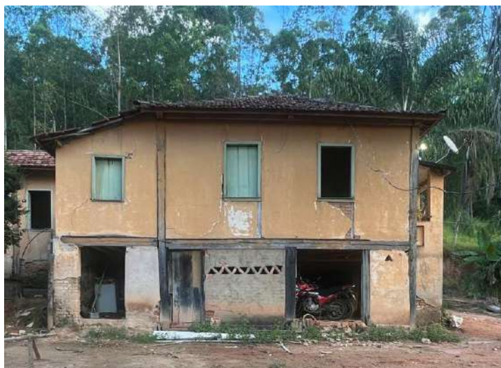
Figura 44- Parte da fachada lateral da fazenda.
