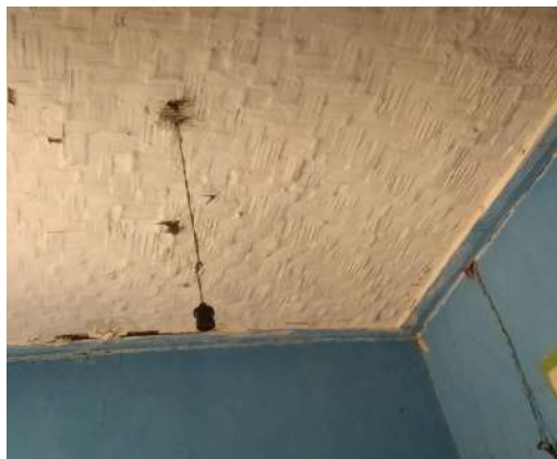
Figura 31- Forro de taquara pigmentado de branco.
