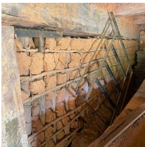
Figura 46- Parede de pau-a-pique presente no porão.
