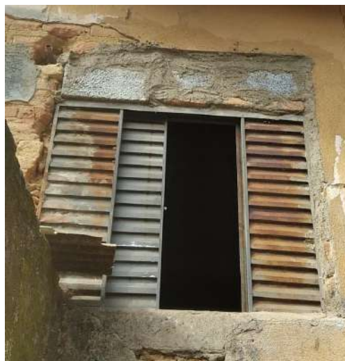
Figura 48- Janela de alumínio presente na cozinha.
