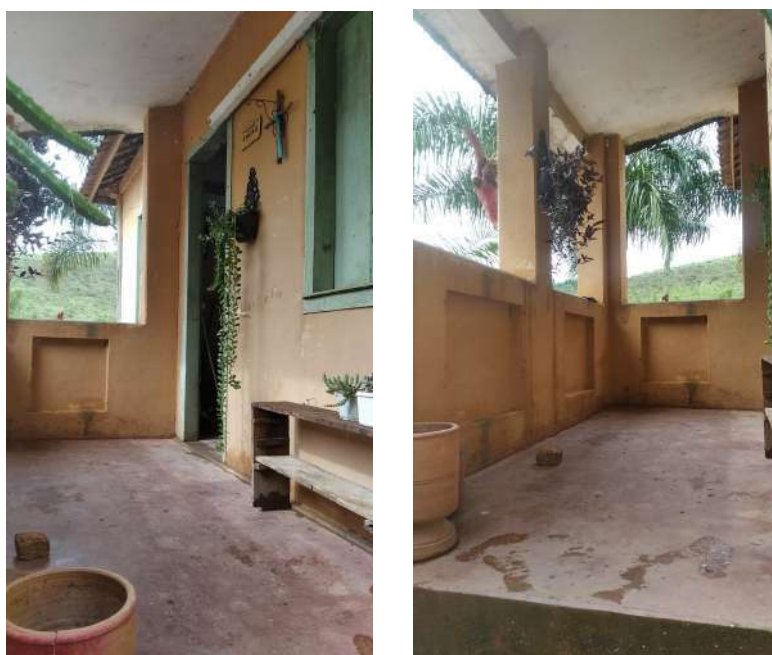
Figura 26 - Detalhes do alpendre, com o revestimento de cimento queimado no piso.
