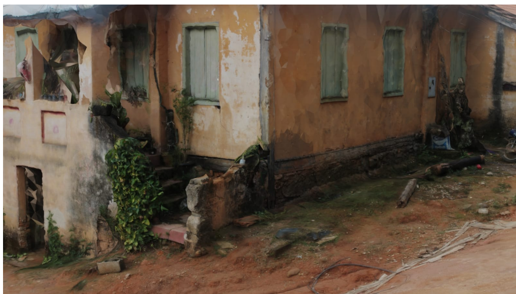
Figura 67- Foto criada a partir do modelo 3D gerado pela nuvem de pontos.
