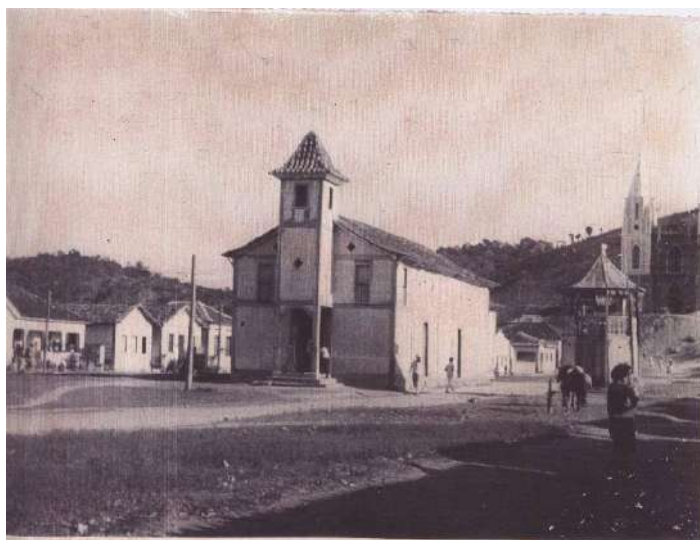
Figura 6 - Foto onde mostra a antiga capela a frente e a atual igreja sendo construída aos fundos.
