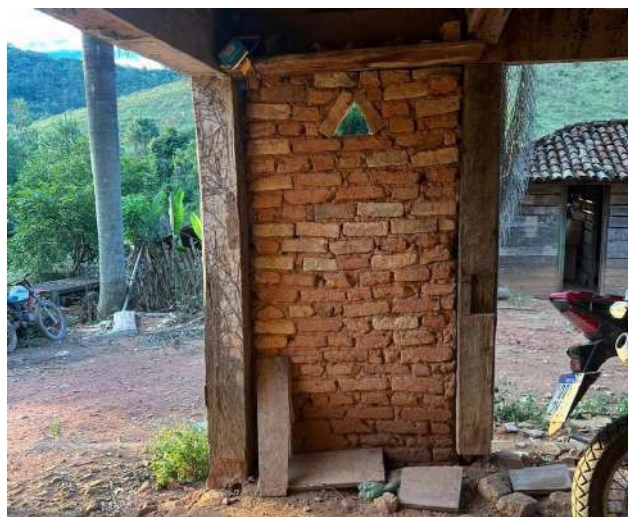
Figura 47- Parede com tijolos maciços aparentes.
