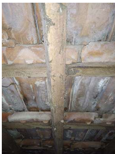
Figura 50- Detalhes do telhado com vestígios de xilófagos. Figura 51- Umidade presente no forro de taquara.
