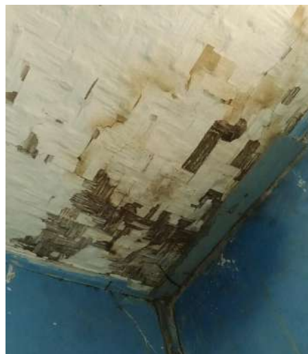
Figura 50- Detalhes do telhado com vestígios de xilófagos. Figura 51- Umidade presente no forro de taquara.
