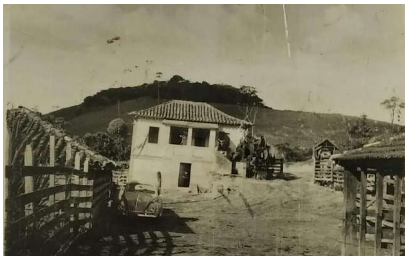
Figura 16- Foto da fachada provavelmente ainda sem intervenção.
