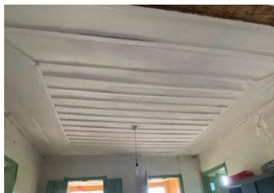
Figura 30- Detalhe do forro camisa e saia.
