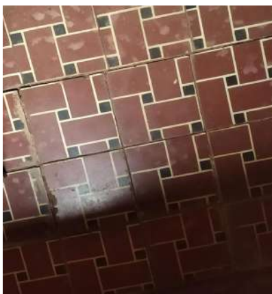
Figura 36- Piso de ladrilho hidráulico presente na sala.
