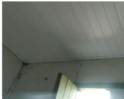
Figura 32- Forro de PVC presente em um dos quartos.
