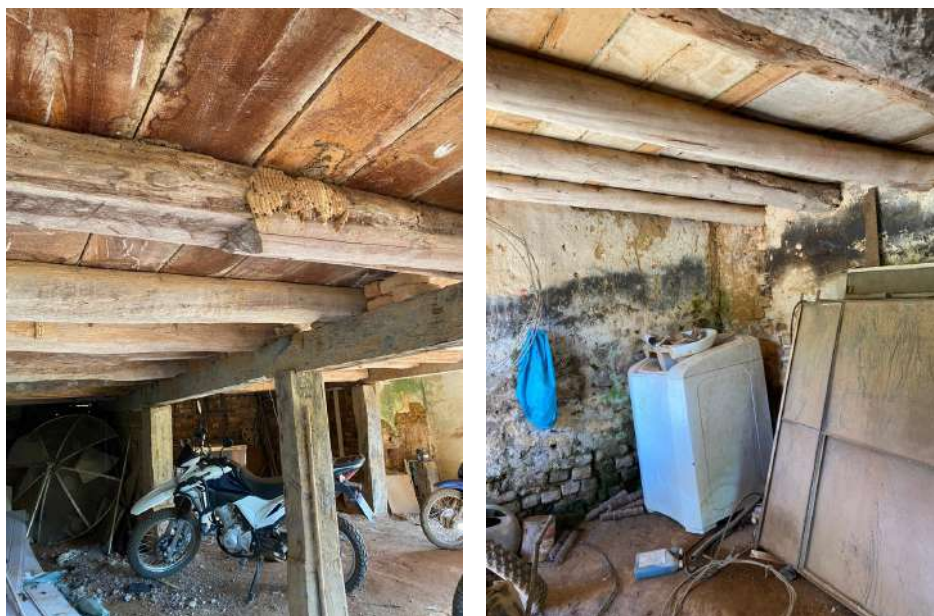
Figura 45- Detalhes da estrutura do piso superior presente no porão.
