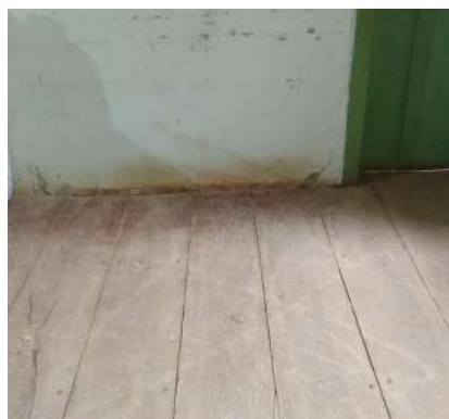
Figura 29- Detalhe do piso de tábua corrida.
