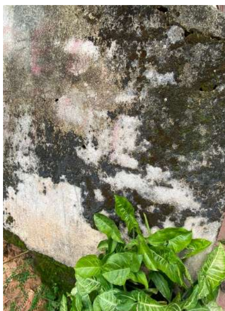
Figura 56- Presença de vegetação de pequeno porte e biofilme.
