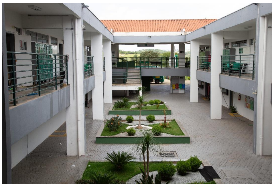
Figura 52 – Bloco Pedagógico – pátio interno e paisagismo
