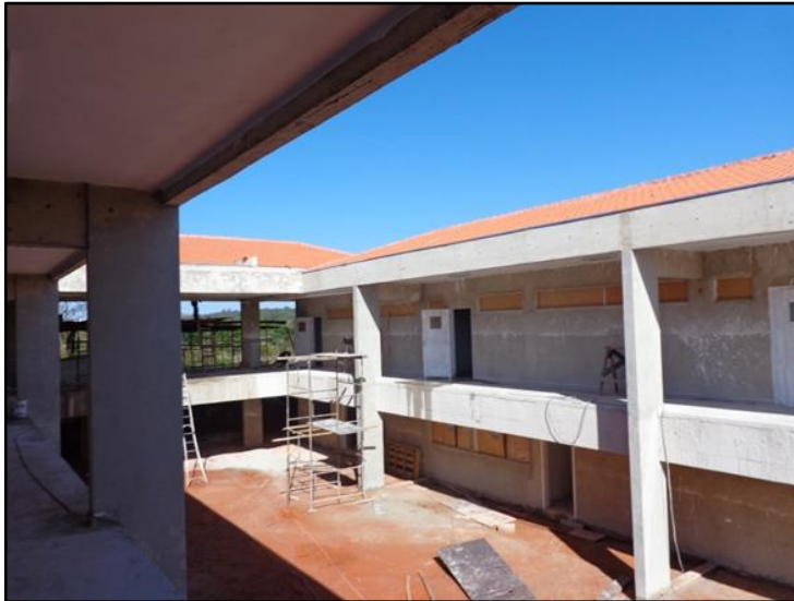
Figura 63 - Obra com Pilares e Vigas em Concreto Armado
