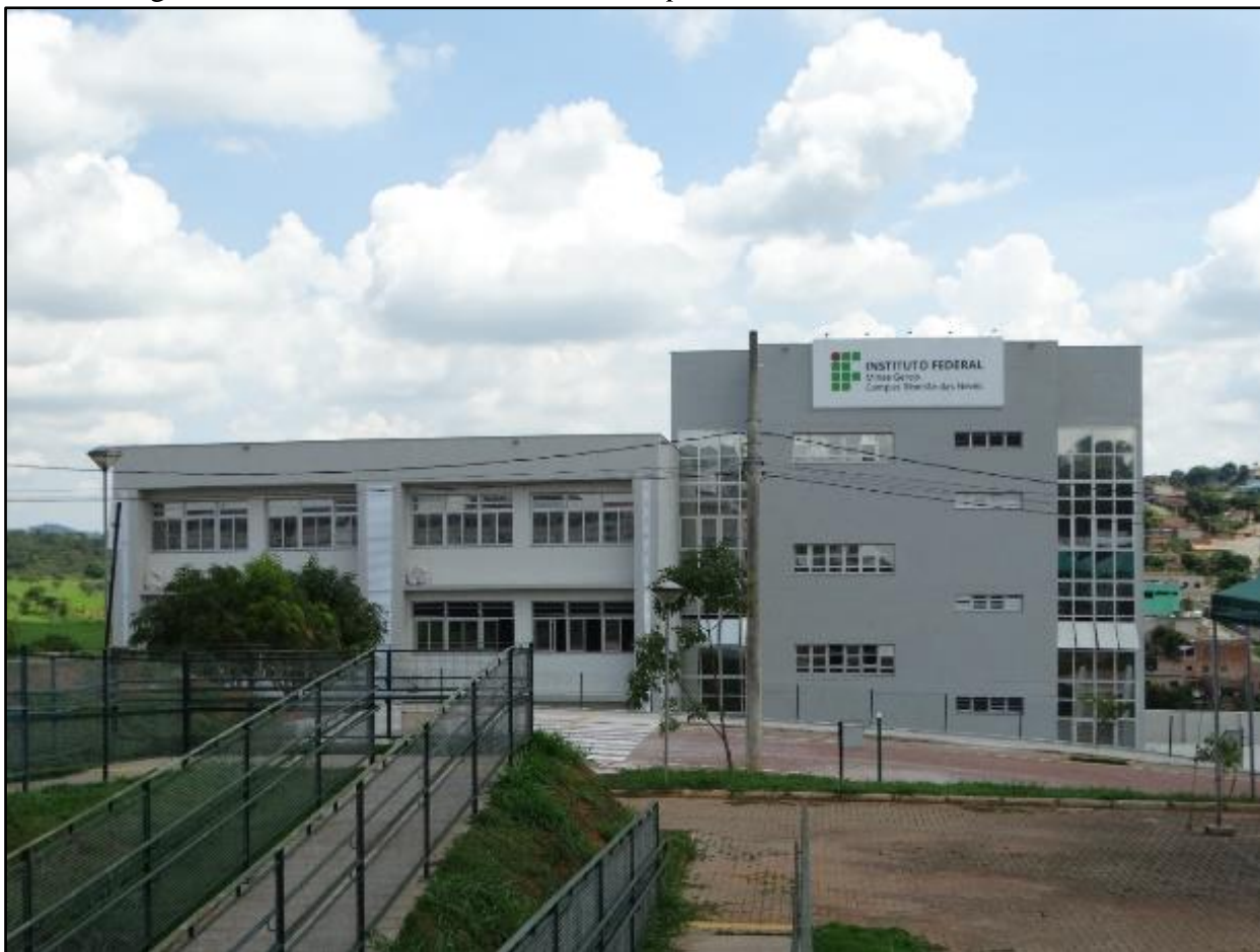
Figura 45 – Novo Bloco Didático do Campus Ribeirão das Neves
