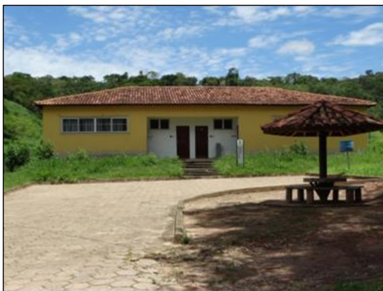
Figura 25 – Sala de aula isolada
