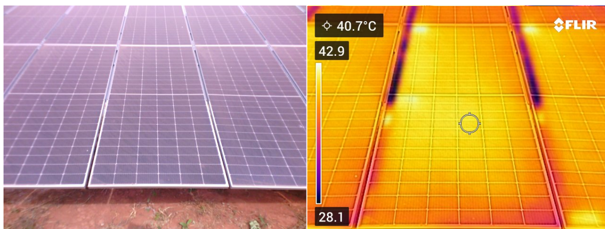
Figura 29 – Análise Termográfica 3 - Tracker .
