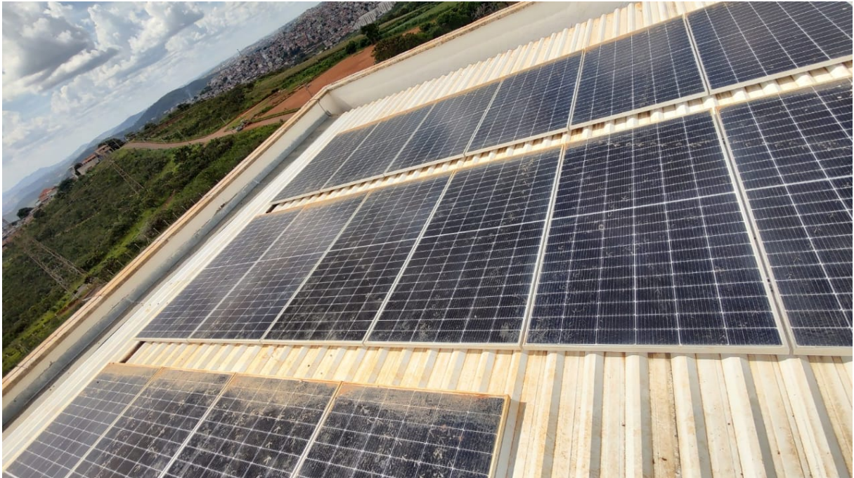
Figura 22 – Usina Telhado após uma semana de limpeza
