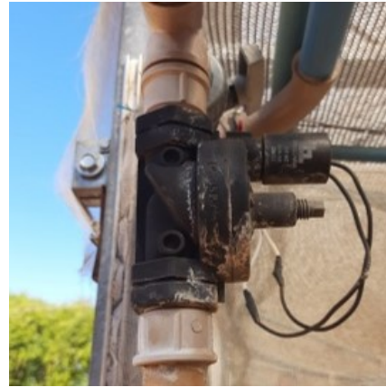
(b) Válvula após manutenção.
