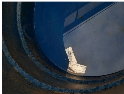
(c) Caixa d'água após o reparo.
