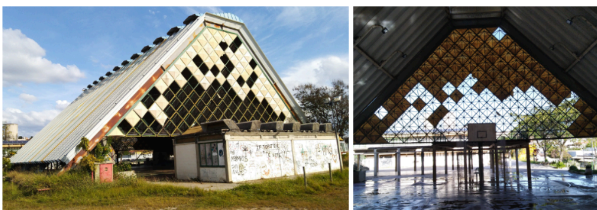
Figura 18 - Ginásio / Quadra antes da reforma
