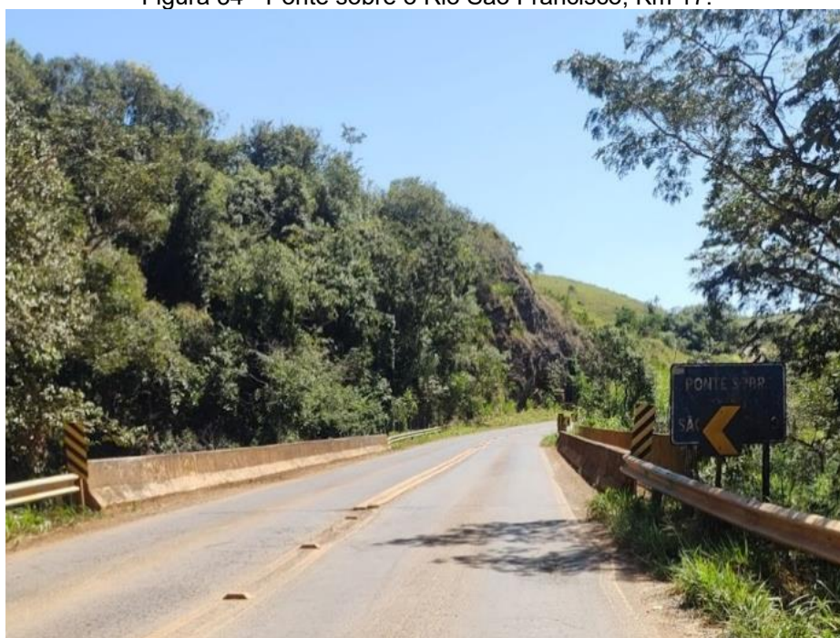
Figura 34 - Ponte sobre o Rio São Francisco, Km 17.
