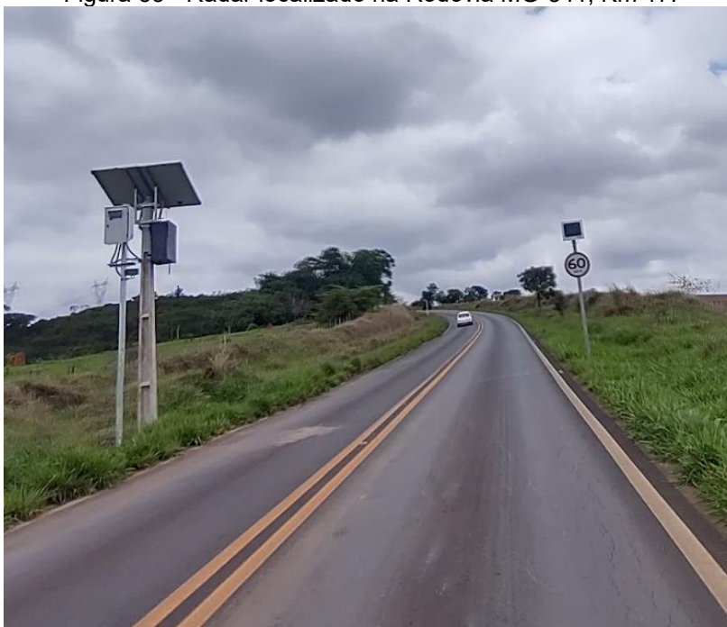
Figura 33 - Radar localizado na Rodovia MG-341, Km 17.
