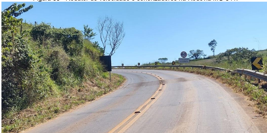
Figura 35 - Redutor de velocidade e sonorizadores na Rodovia MG-341.
