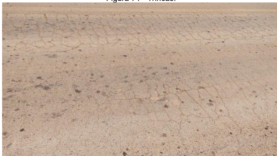
Figura 71 - Trincas.
