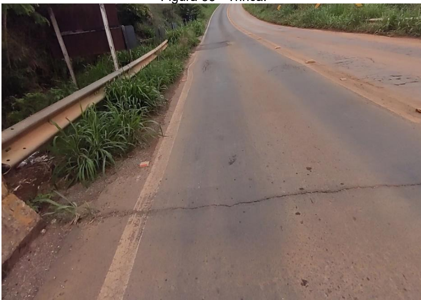
Figura 53 - Trinca.
