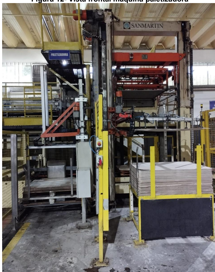
Figura 12- Vista frontal máquina paletizadora
