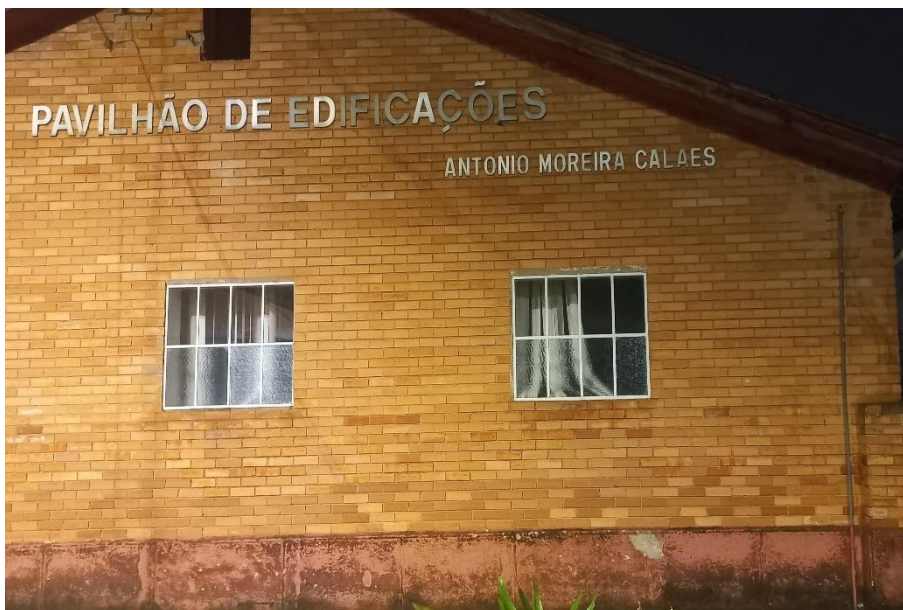
Figura 16 - Pavilhão de Edificações
