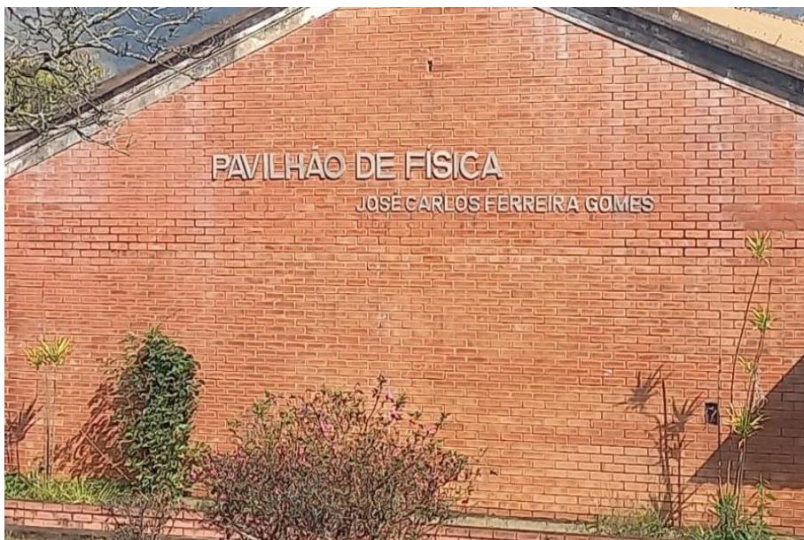
Figura 5 - Pavilhão De Física
