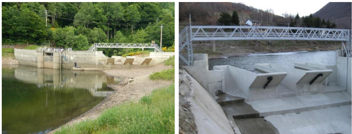
Figura 16 - Vista de montante e jusante do PKW da Barragem de Goulours, respectivamente.
