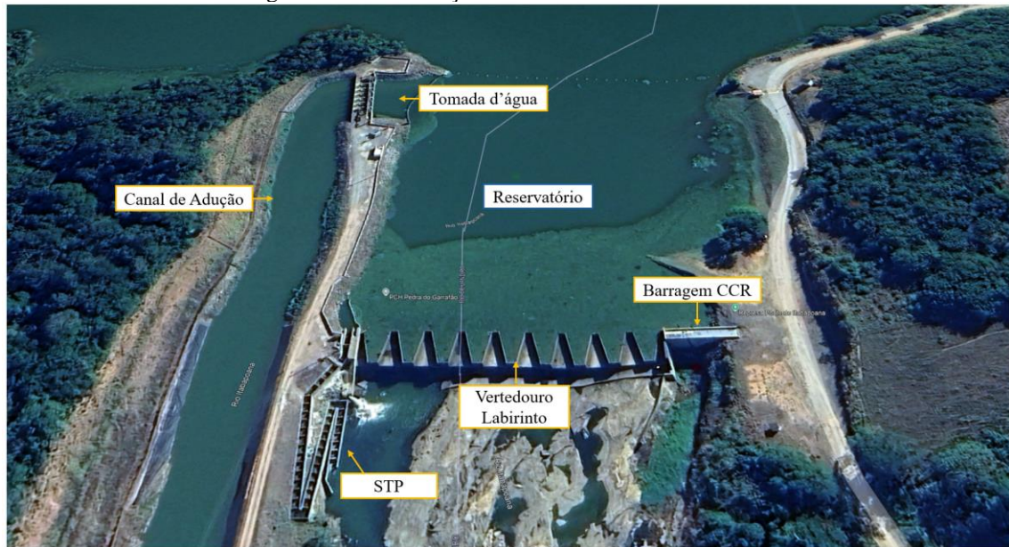
Figura 23 - Identificação das estruturas do barramento.
