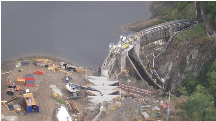
Figura 15 – Vista aérea da fase de implementação do PKW na Barragem de Goulours.
