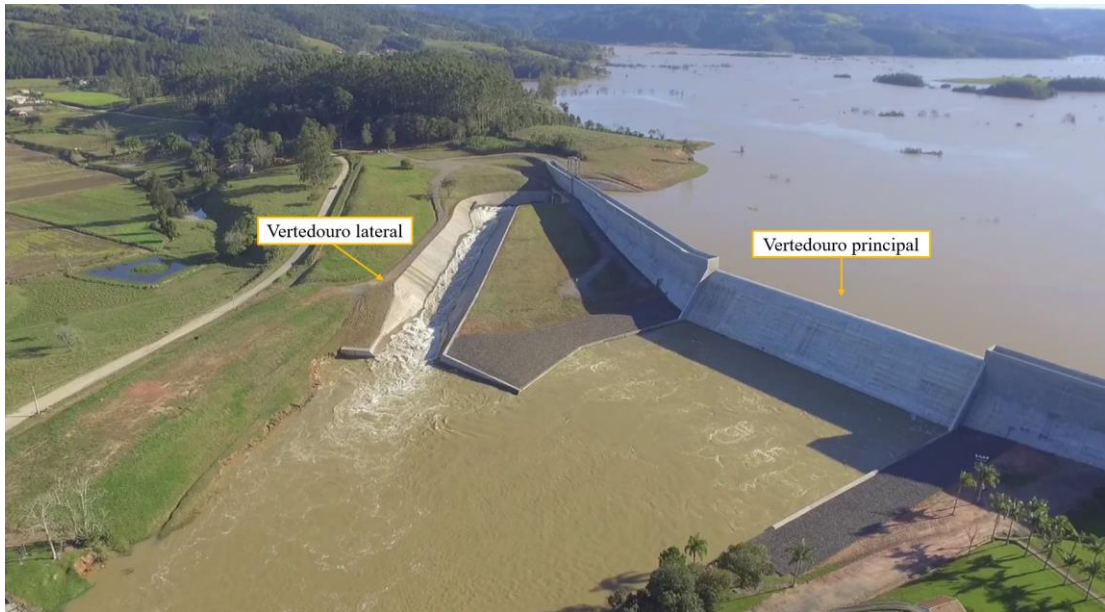
Figura 5 - Vertedouro do tipo canal lateral da barragem de Taió (SC).
