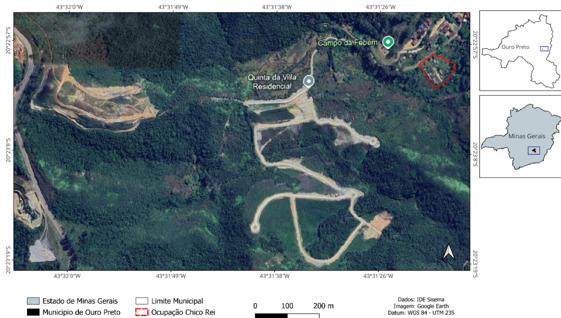
Figura 16 - Proximidade do residencial Quinta da Villa com a área da FEBEM
