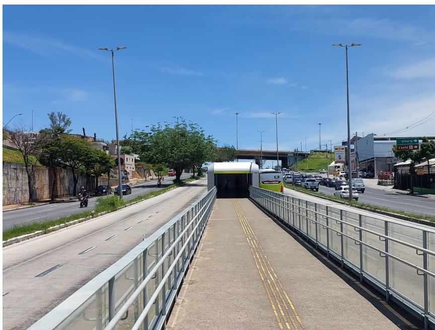
Figura 41: Vista para o Viaduto São Francisco a partir da avenida Presidente Antônio Carlos, Estação Cachoeirinha.
