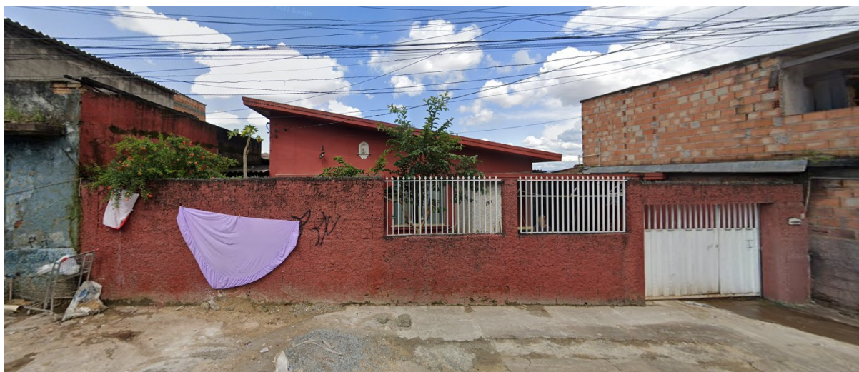
Figura 30: Residência pertencente a uma das entrevistadas, remanescente em área do bairro Nova Cachoeirinha
