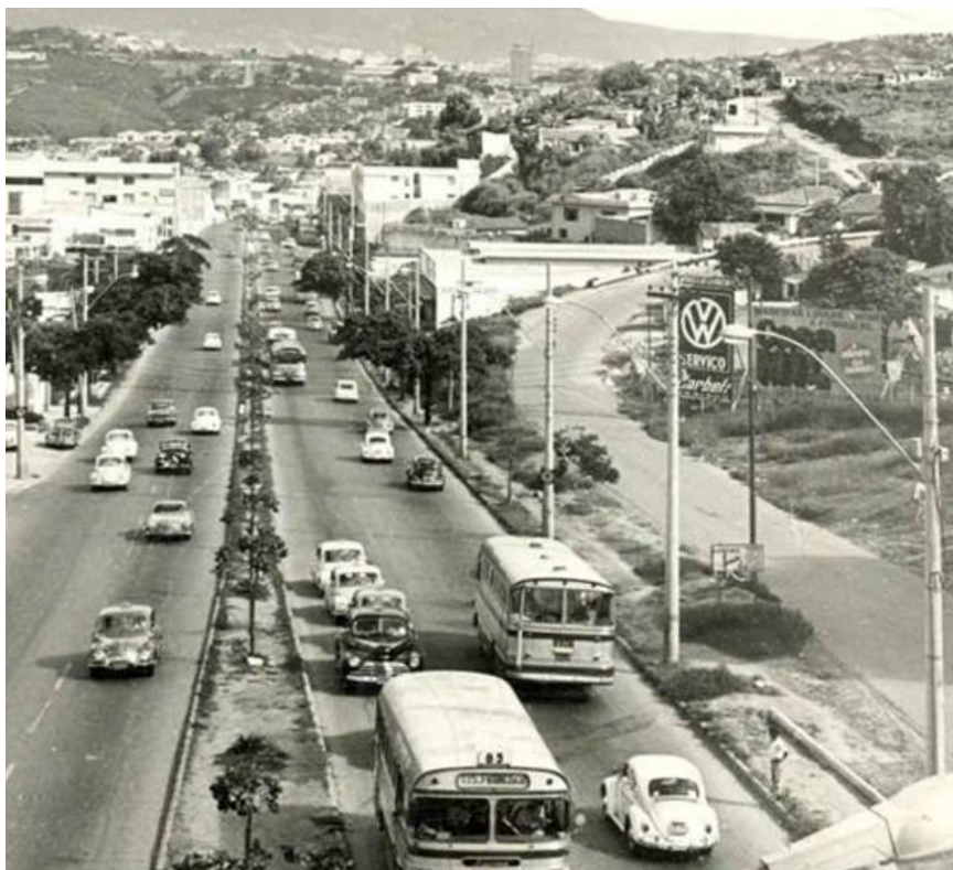
Figura 27: Vista sentido Centro a partir do Viaduto São Francisco.
