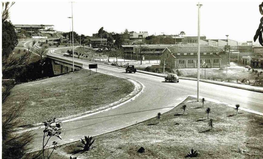
Figura 26: Anel Rodoviário e Viaduto São Francisco com vista para a Praça São Francisco de Assis.
