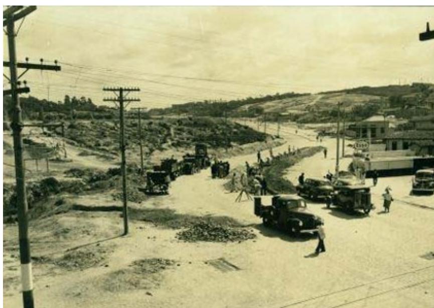
Figura 3: Detalhes dos preparativos para a instalação da linha de bondes para a Pampulha, na avenida Antônio Carlos.
