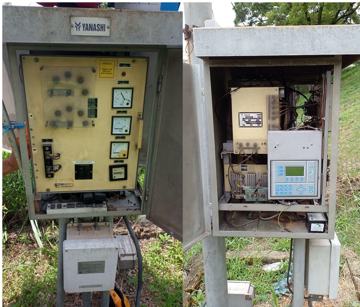
Foto 8 – Automação de um retificador manual
