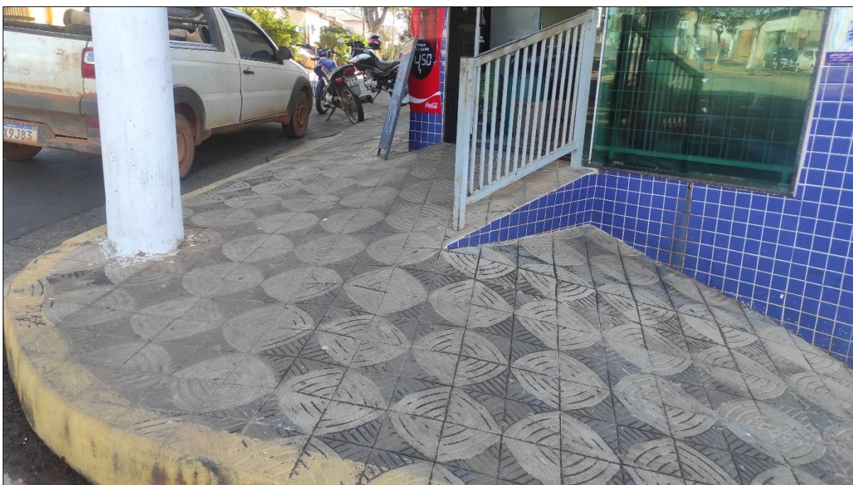
Figura 52: Rampa de acesso a lote comercial.
