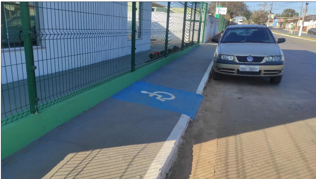
Figura 44: Rebaixamento da calçada na Avenida Aristides Garcia Leão.
