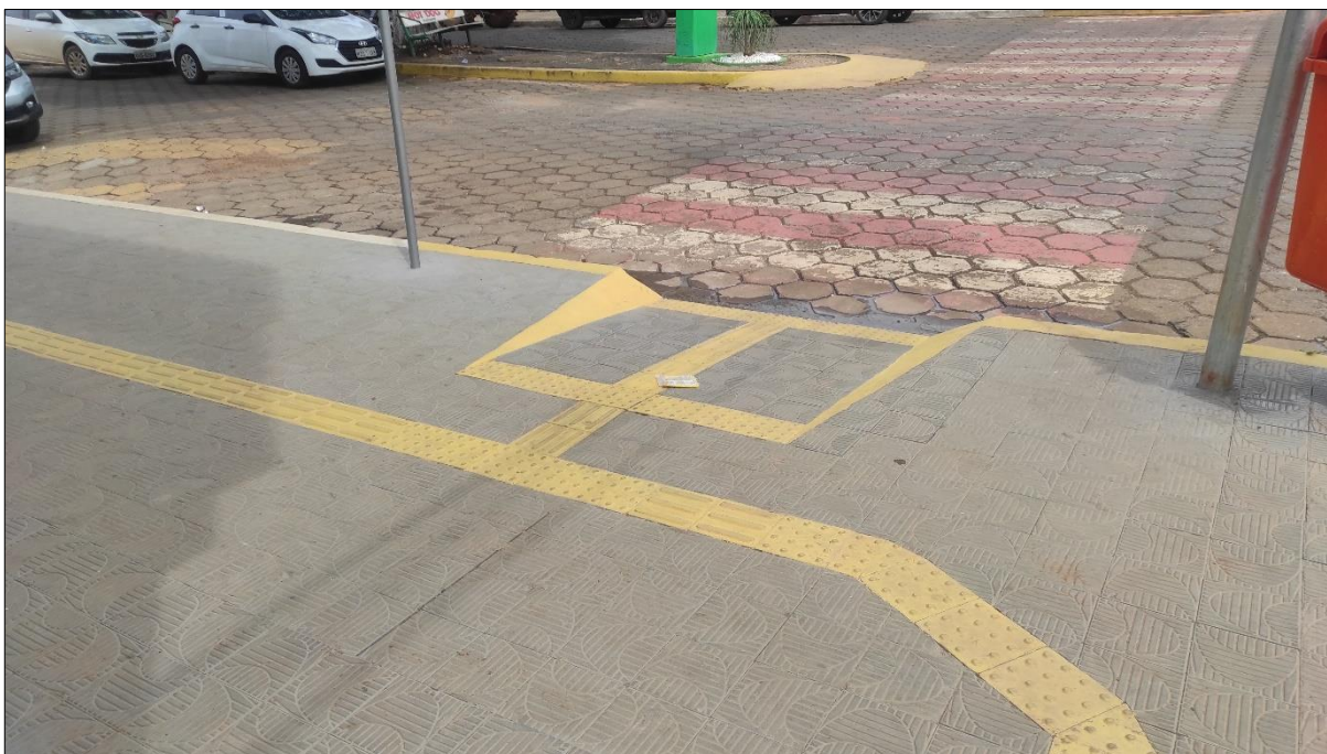
Figura 66: Piso tátil na calçada da Avenida Juscelino Kubitschek.
