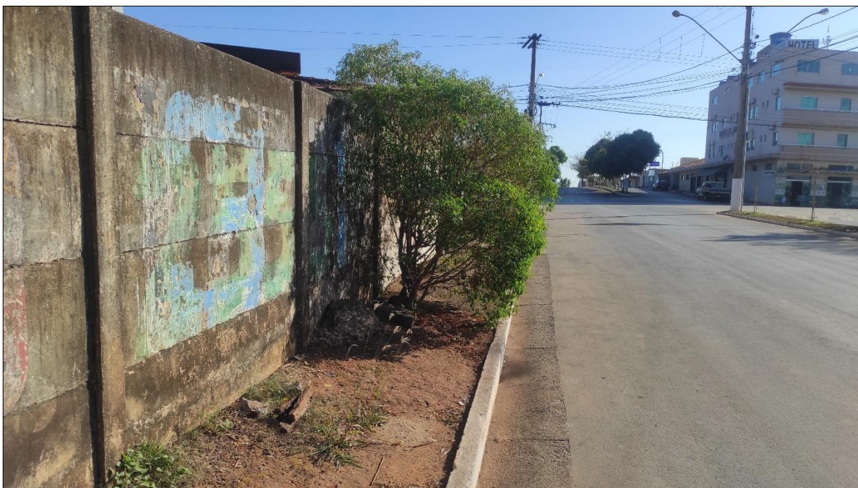
Figura 48: Árvore no meio da calçada na Avenida Aristides Garcia Leão.
