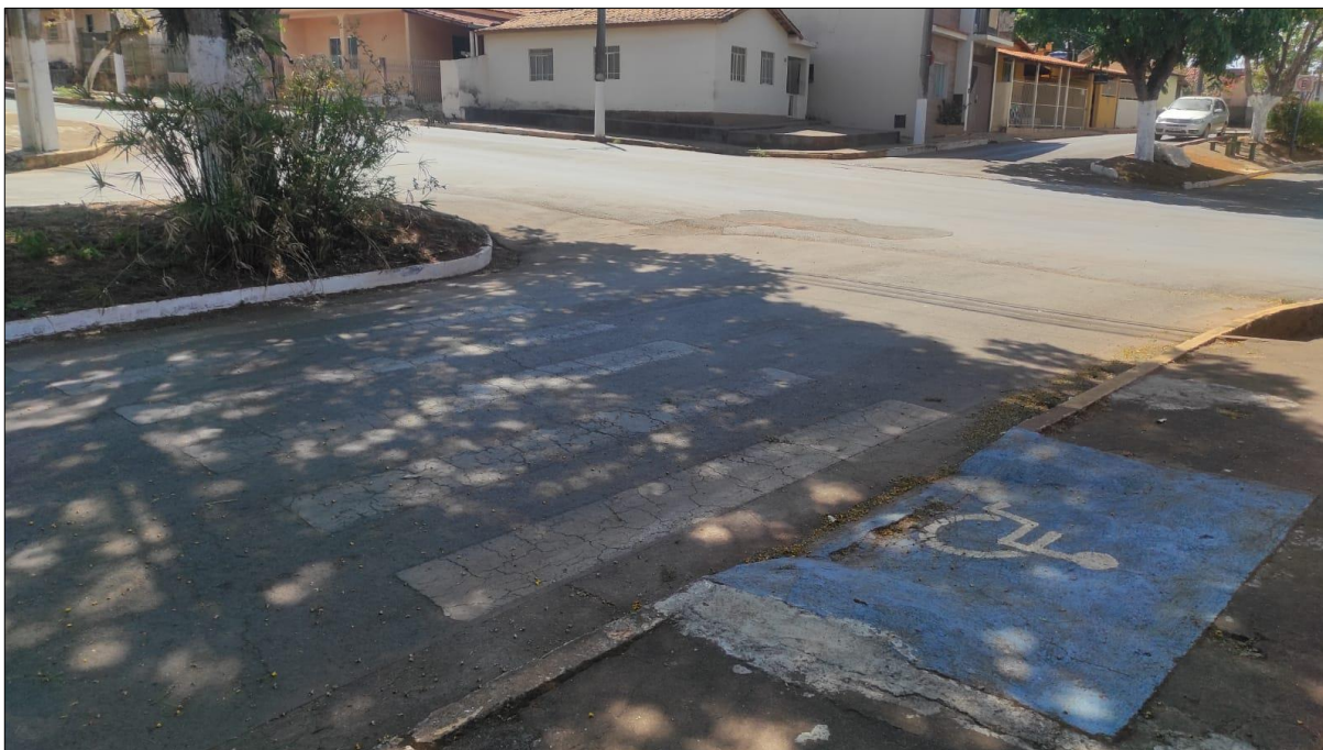
Figura 43: Rebaixamento da calçada na Avenida Primeiro de Janeiro.
