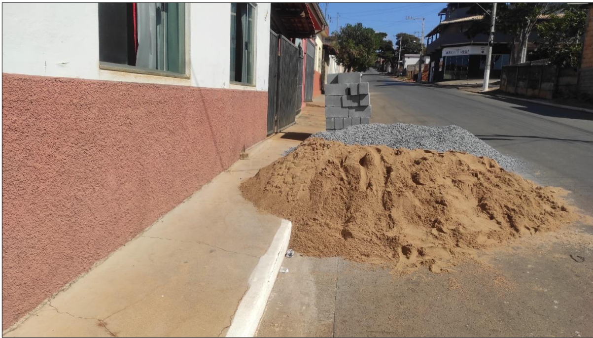
Figura 59: Materiais armazenados na calçada da Rua Professora Mariana Gonzaga.
