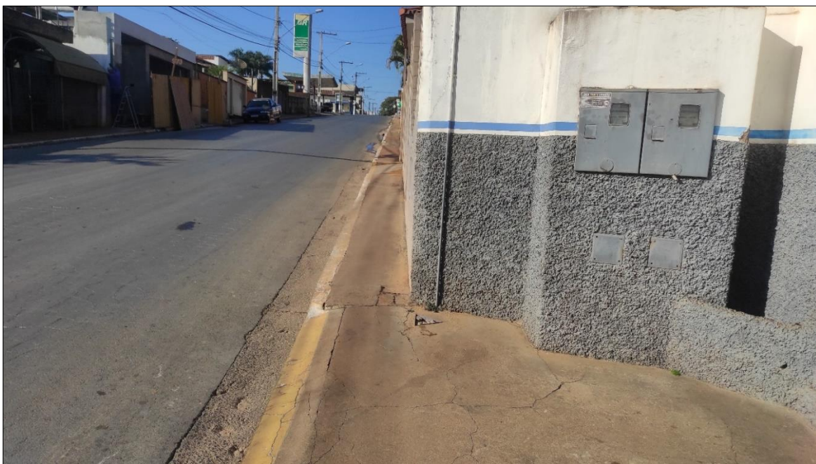
Figura 36: Estreitamento da calçada na Rua Olinto Fonseca.
