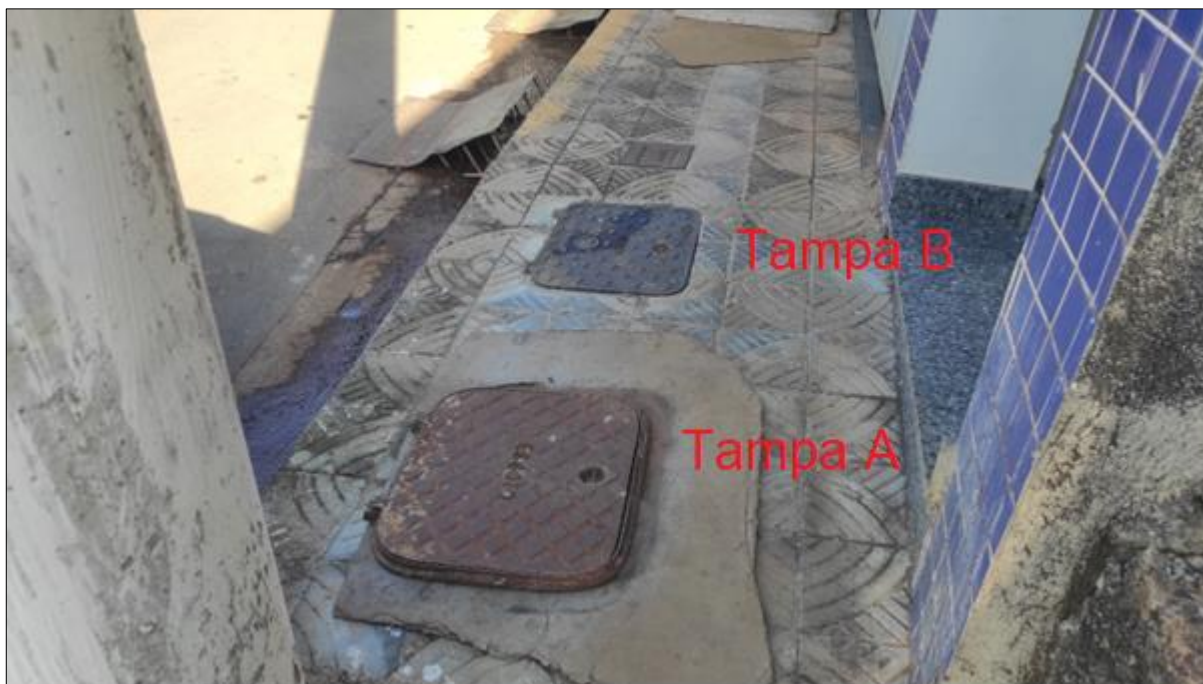
Figura 58: Tampa da caixa de inspeção na calçada da Avenida Jair Leite.
