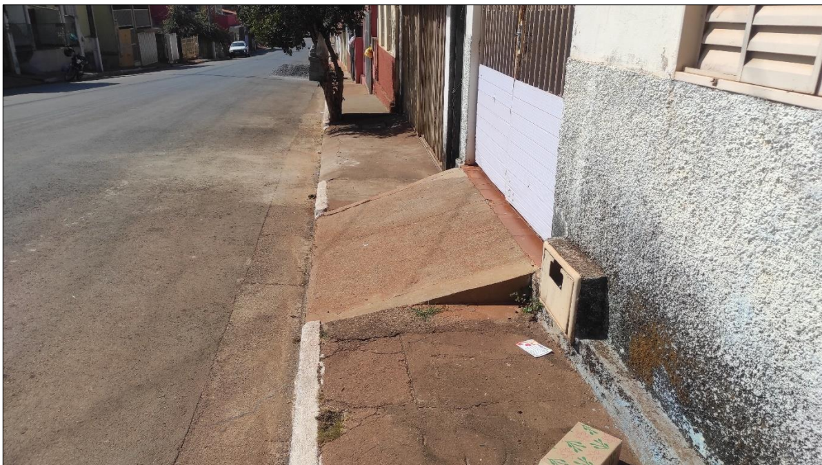
Figura 50: Rampa de acesso a lote lindeiro na Rua Mariana Gonzaga.
