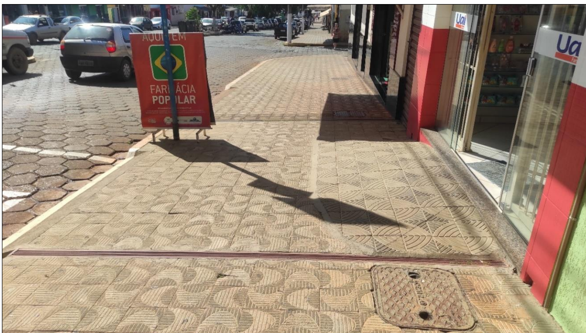
Figura 37: Largura da calçada da Avenida Juscelino Kubitschek.
