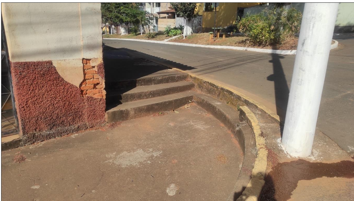
Figura 41: Escada na calçada da Avenida Primeiro de Janeiro.
