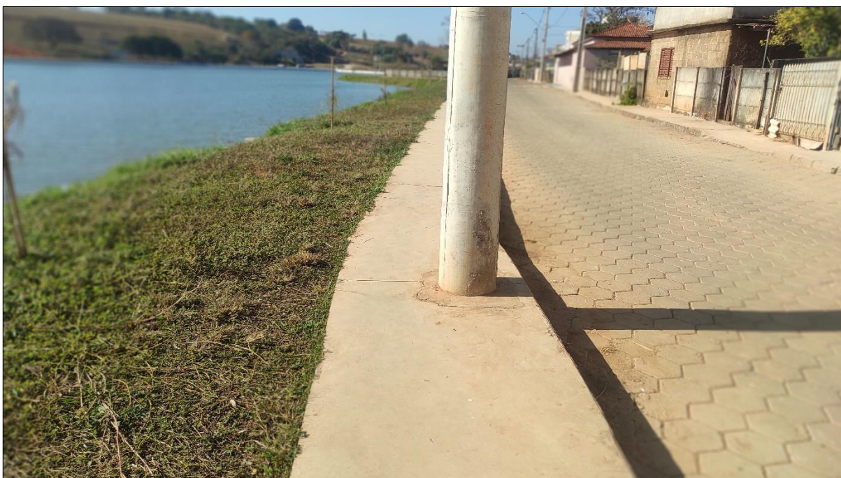
Figura 46: Presença de postes na calçada da Rua Copacabana.
