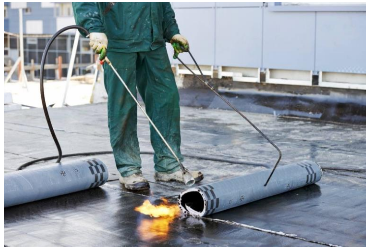
Figura 24 - Ilustração da forma de aplicação de manta asfáltica.
