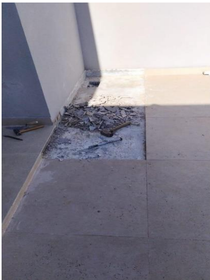
Figura 38 - Retirada do porcelanato.
