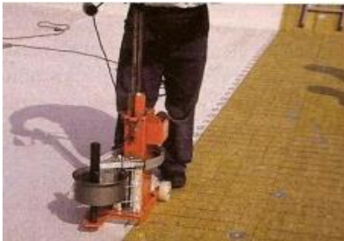
Figura 23 - Fixação automática com parafusos e arruelas especiais.
