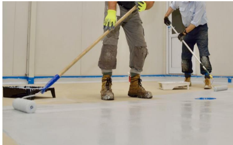
Figura 30 - Aplicação de Resina Epóxi.
