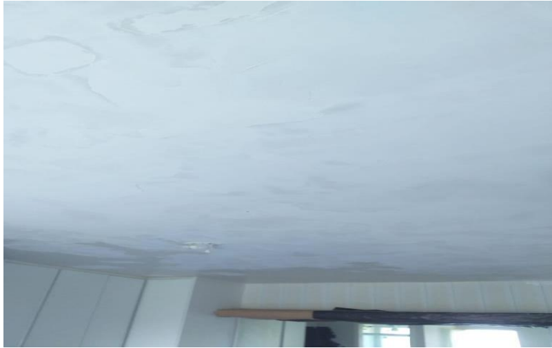
Figura 40 - Reparo sendo realizado no revestimento do teto.
