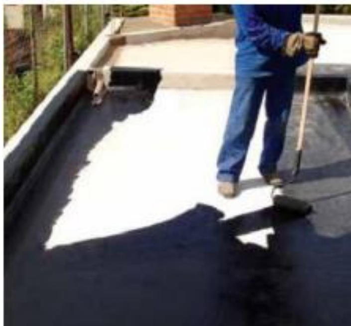
Figura 19 - Aplicação de membrana asfáltica a frio.
