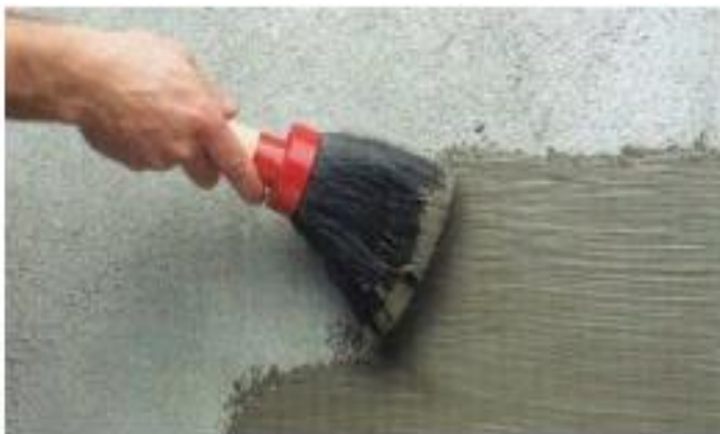
Figura 27 - Aplicação de argamassa polimérica 2.
