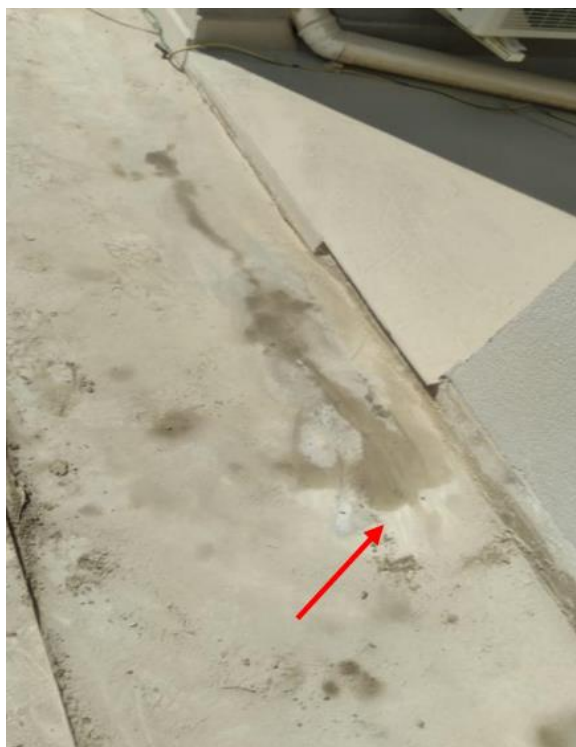
Figura 39 - Área preenchida com graute, pronta para aplicar a nova impermeabilização.
