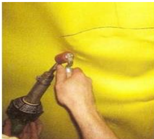
Figura 22 - Solda em manta de PVC com equipamento manual.
