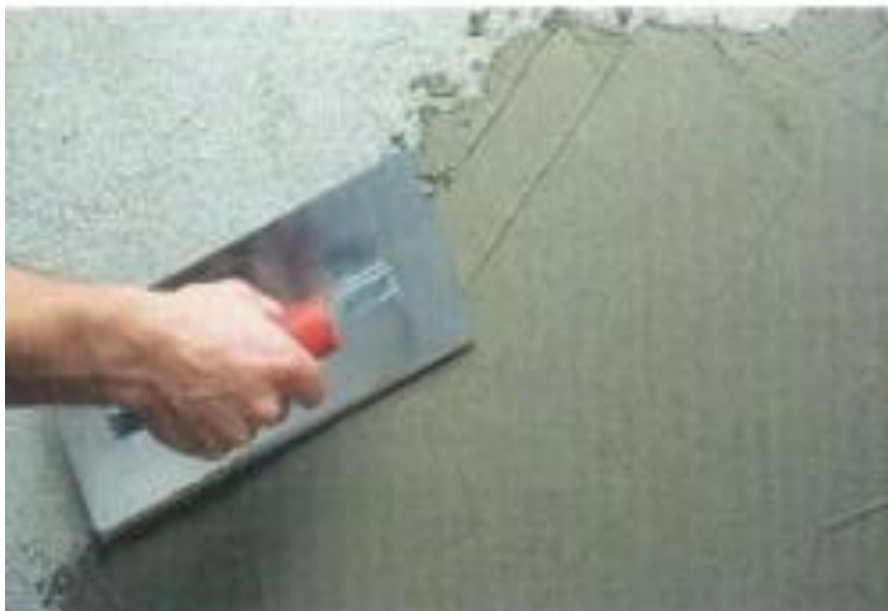
Figura 26 - Aplicação de argamassa polimérica 1.
