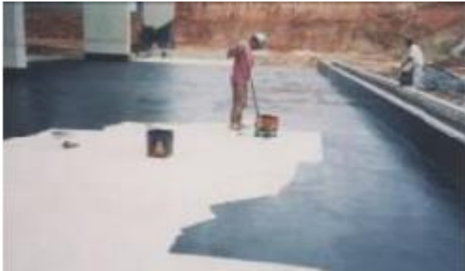
Figura 18 - Execução de membrana de asfalto a frio.
