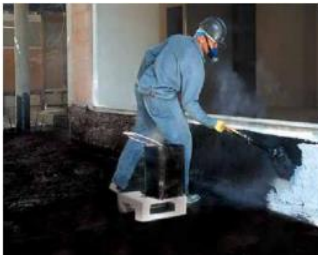
Figura 20 - Execução de membrana de asfalto a quente.
