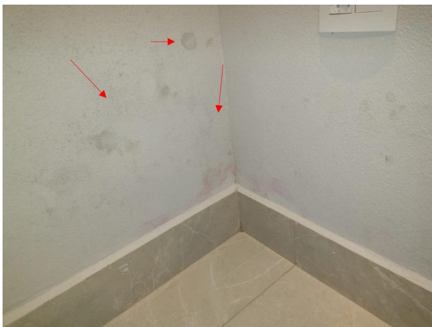
Figura 36 - Infiltração em parede de muro de arrimo.
