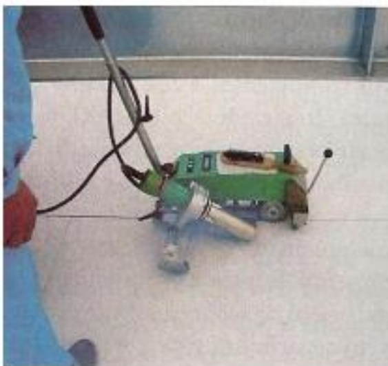
Figura 21 - Solda em manta de PVC com equipamento automático.
