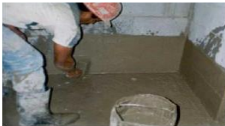
Figura 25 - Aplicação de membrana acrílica.
