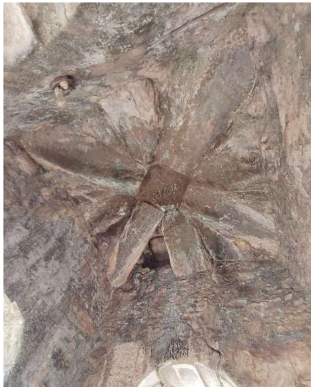
Figura 3: Estrutura interna do coruchéu, Matriz de Nossa Senhora da Boa Viagem, em Itabirito. Foto: Gustavo Bastos, Agosto de 2023.
