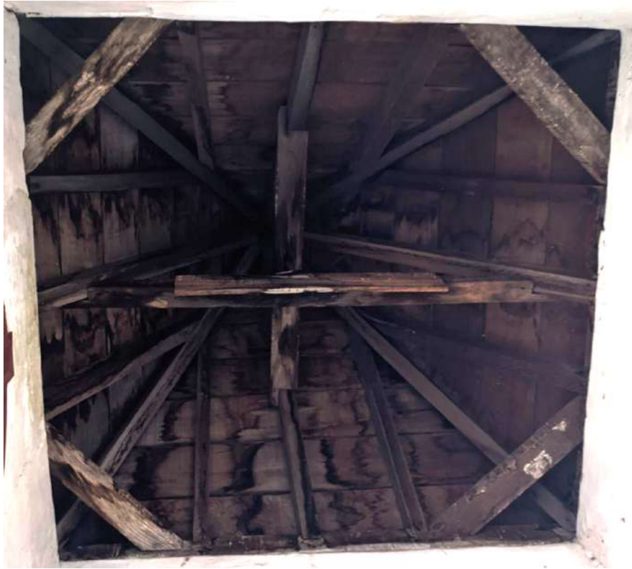
Figura 2: Estrutura do telhado com a base do pináculo na Capela de Nossa Senhora da Expectação do Parto, em Sabará. Foto: Gustavo Bastos, Janeiro de 2023.
