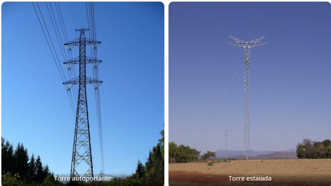
Figura 2 - Torre Autoportante x Estaiada
