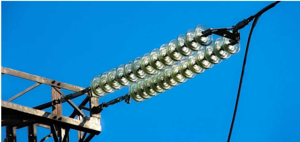
Figura 5 – Isolador de vidro para linha de transmissão.
