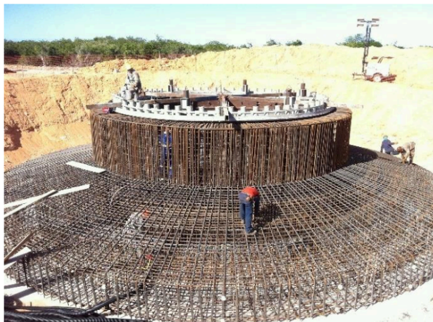
Figura 11 - Armadura de uma sapata circular para aerogerador
