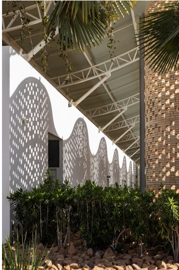
Figura 10: Entrada de iluminação natural e ventilação no hospital
