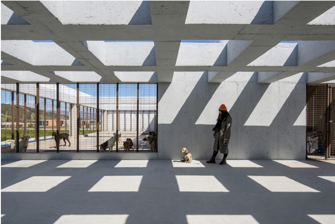
Figura 17: Cobertura desenvolvida para obter iluminação natural
