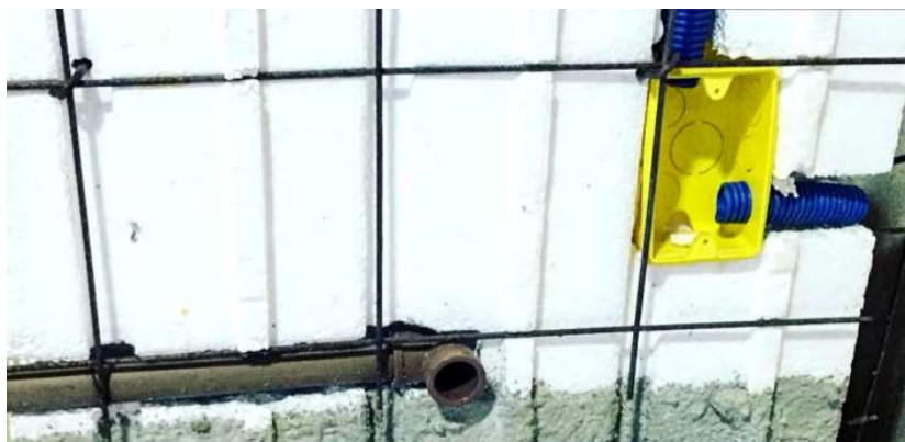
Figura 31 – Instalações hidráulicas e elétricas
