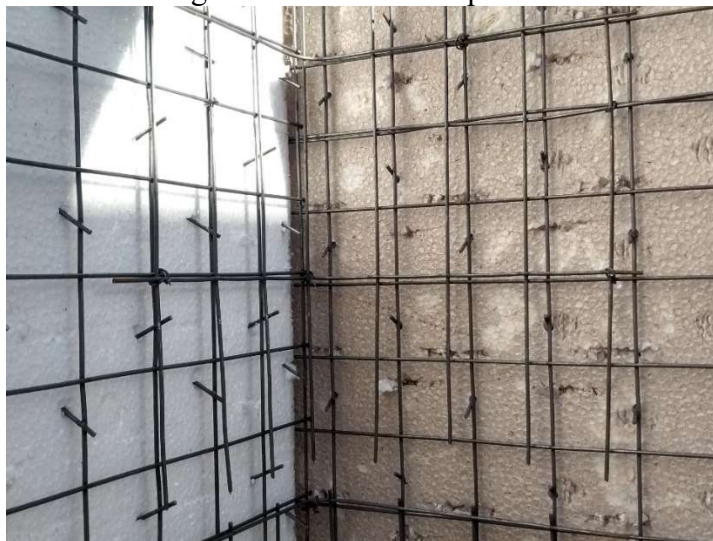
Figura 2 – Encontro de paredes
