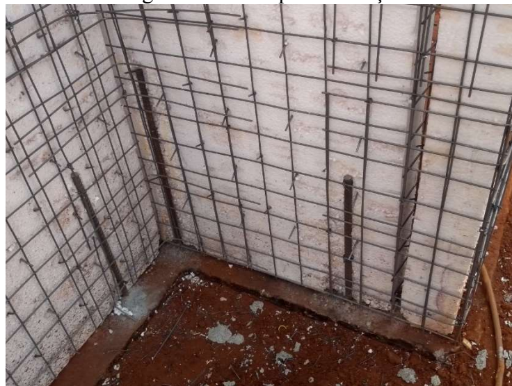
Figura 1 – Arranques Fundação
