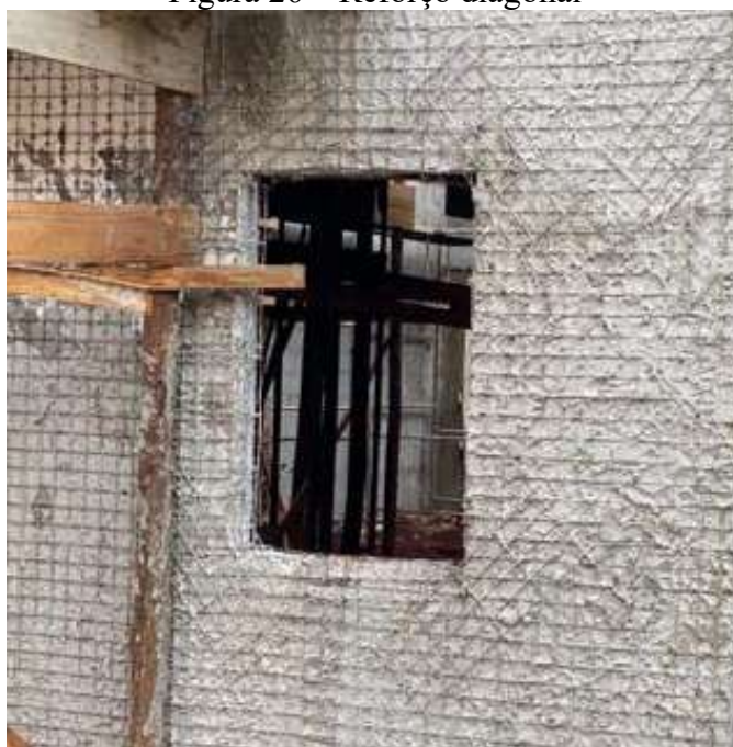
Figura 26 – Reforço diagonal
