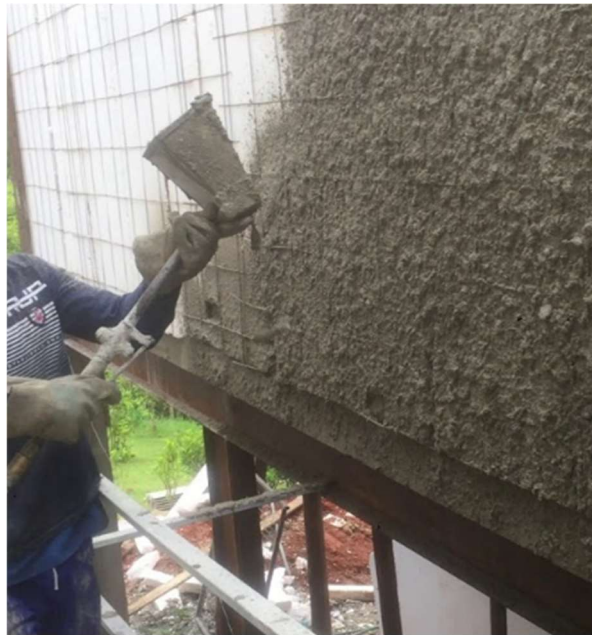
Figura 32 – Projeção da Argamassa
