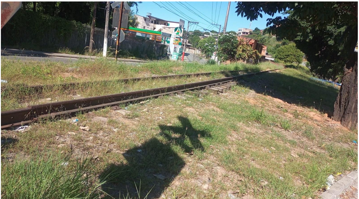
Figura 40 – Fotografia da linha férrea na entrada do bairro Vale Esperança, Cariacica-ES.
