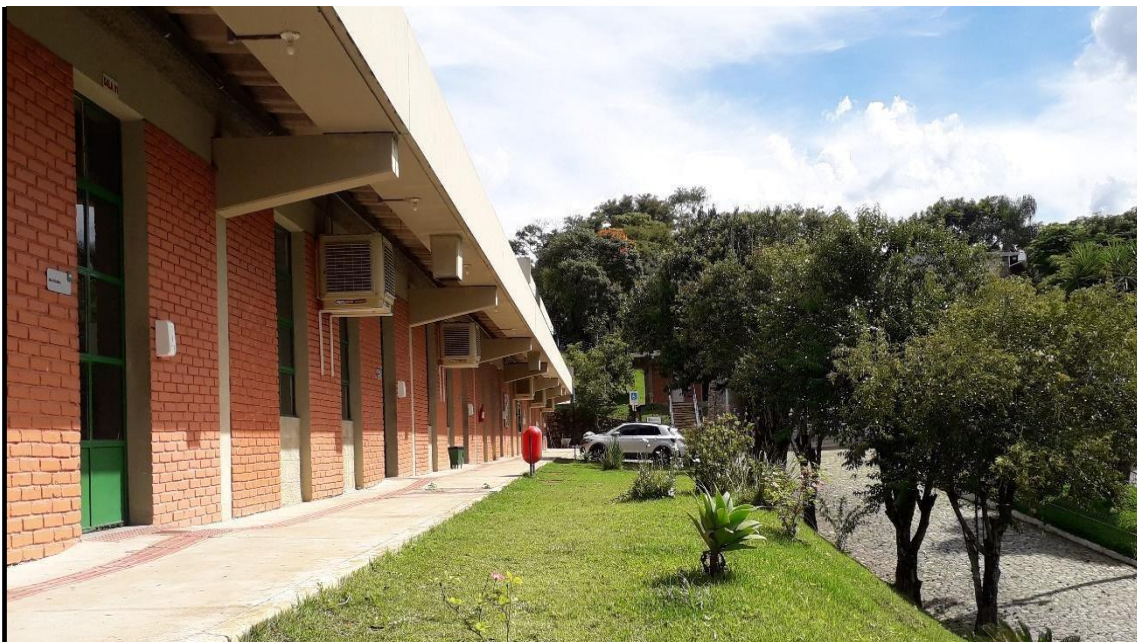
Figura 18 - Salas de aulas (parte externa)
