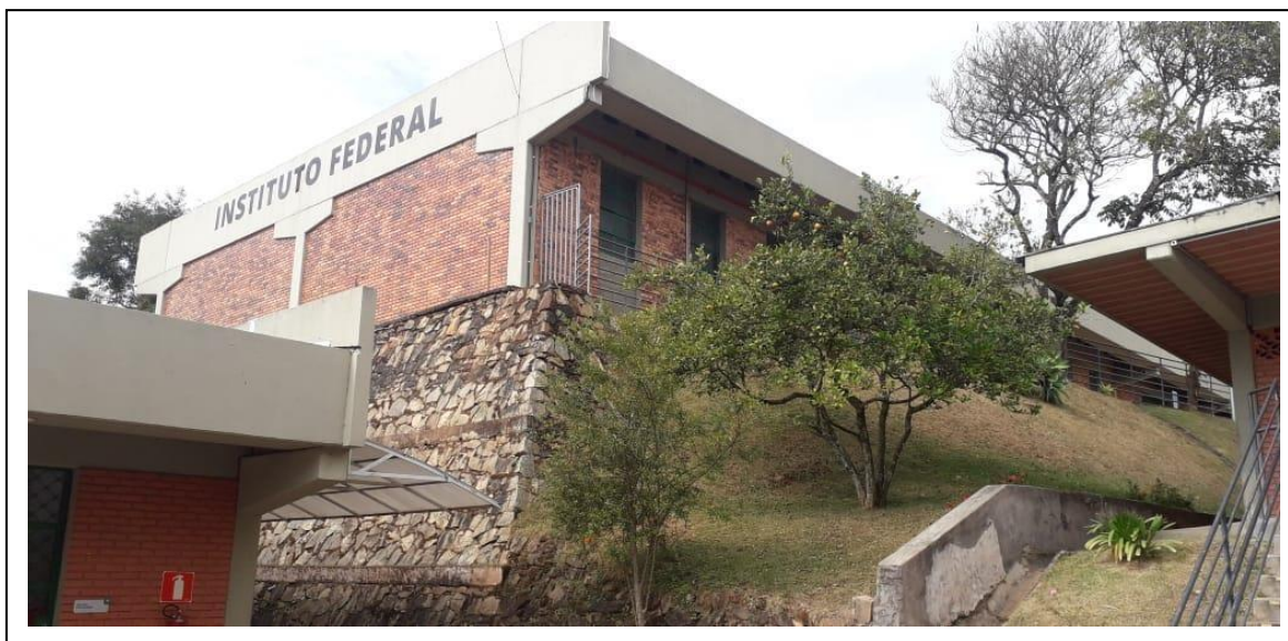
Figura 6 - Prédio onde atualmente estão localizados os laboratórios de Mecânica e Eletrotécnica
