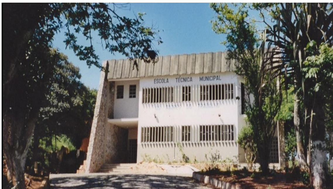
Figura 36 - Fachada da Escola Técnica Municipal Os Padres do Trabalho - década de 2000
