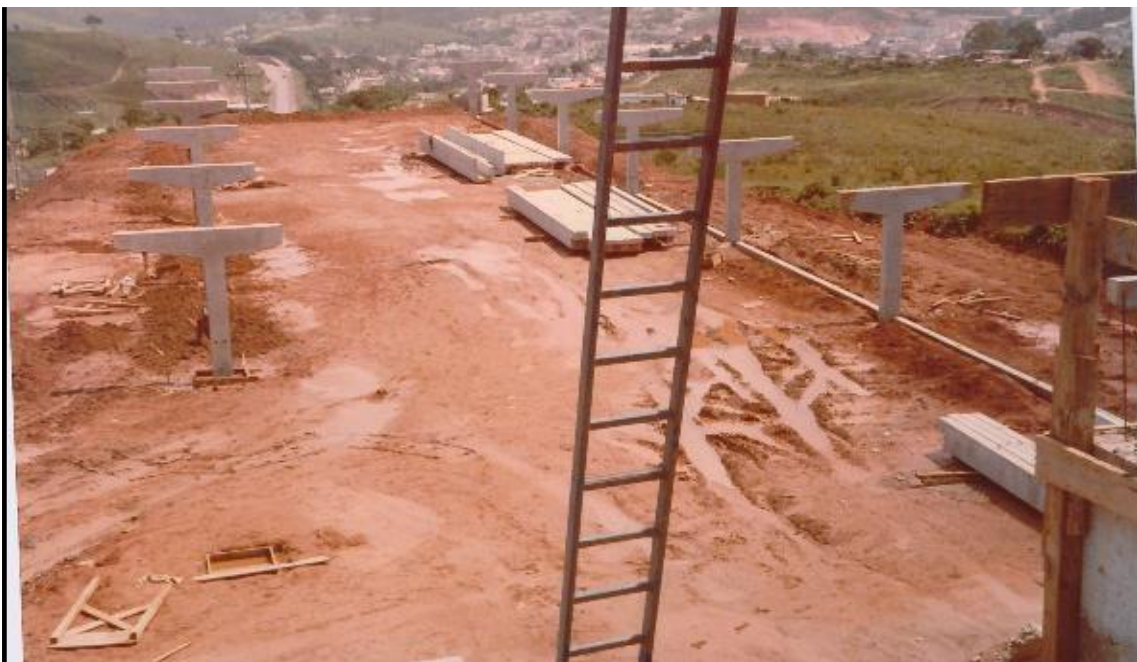
Figura 35 - Obras de construção dos prédios da Escola Técnica “Os Padres do Trabalho” - década de 1960
