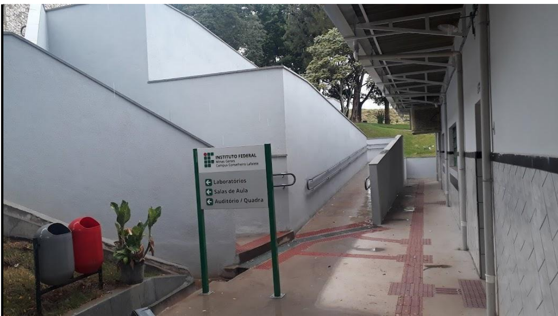
Figura 19 - Rampas de Acessibilidade
