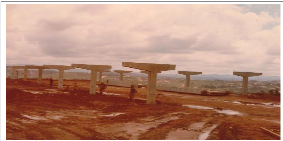
Figura 5 - Obras de construção da Escola Técnica Os Padres do Trabalho na década de 1980
