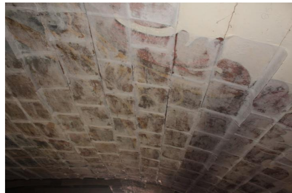
Figura 15 - Detalhe do faceamento do medalhão central.
