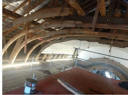
Figura 32 - Alinhamento de novas peças de cambotas.
