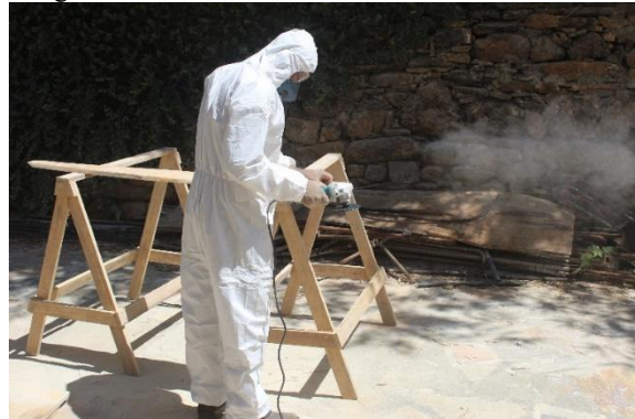
Figura 42 - Lixamento do verso do forro da nave.
