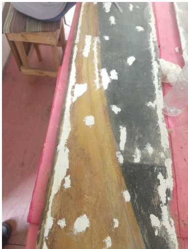
Figura 53 - Detalhe de nivelamento do forro da nave com acabamento.
