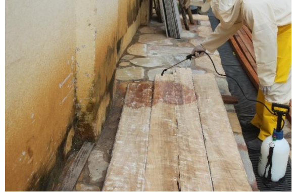
Figura 44 - Aplicação de cupinicida nas tábuas que apresentavam frestas ou perda de suporte.
