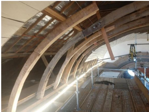
Figura 31 - Detalhe de união entre cambotas barras rosqueadas.
