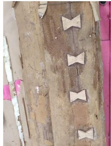
Figura 40 - Inserção de enxertos, borboletas para contenção de trincas.
