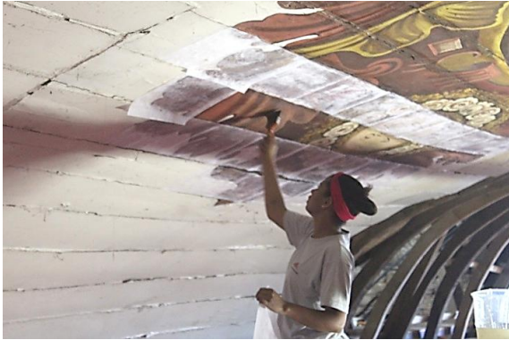
Figura 12 - Aplicação CMC diluído em Água (3:1) nas tábuas do medalhão central do forro da nave.
