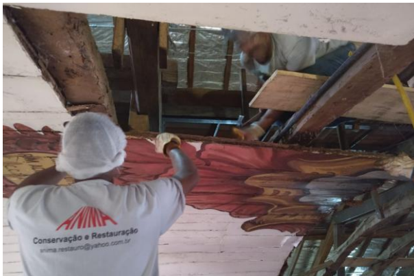
Figura 16 - Processo de desmonte das tábuas centrais do forro da nave.
