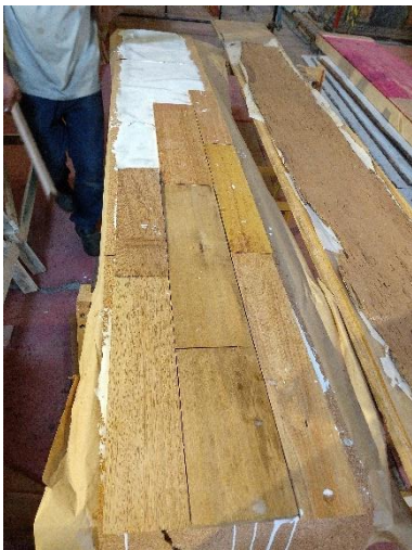
Figura 37 - Posicionamento dos novos tacos sobre o adesivo de contato.
