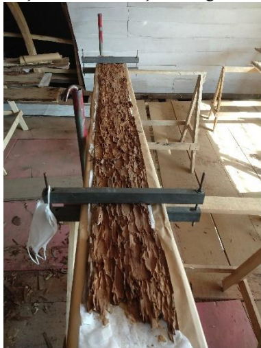
Figura 33 - Situação estrutural das tábuas do forro após a remoção das intervenções irregulares.
