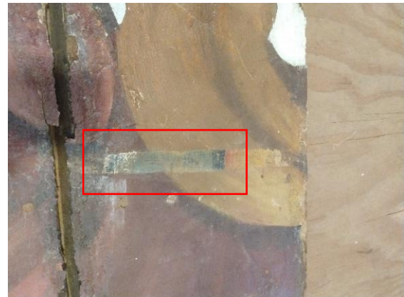
Figura 46 - Abertura de janelas de prospecções manuais.
