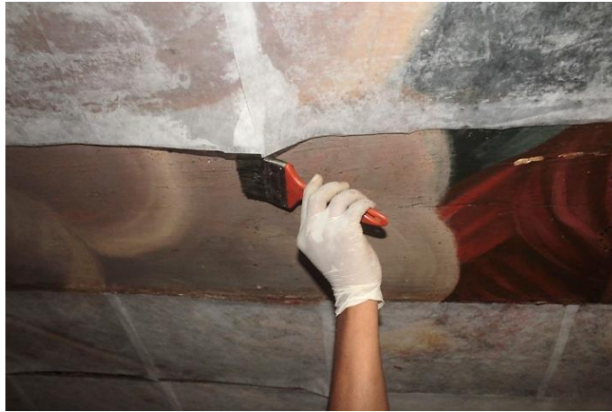
Figura 11 - Processo de higienizações das tábuas do medalhão central do forro da nave com pinceis de cerdas macias.
