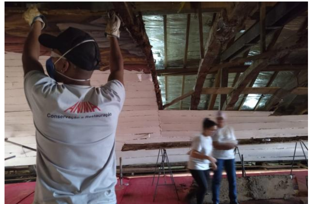
Figura 17 – Desmonte das tábuas do 7o quadrante do forro da nave.
