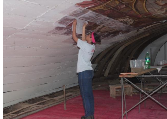
Figura 13 - Aplicação de papel Pelon® sob camada de CMC nas tábuas do medalhão central do forro.
