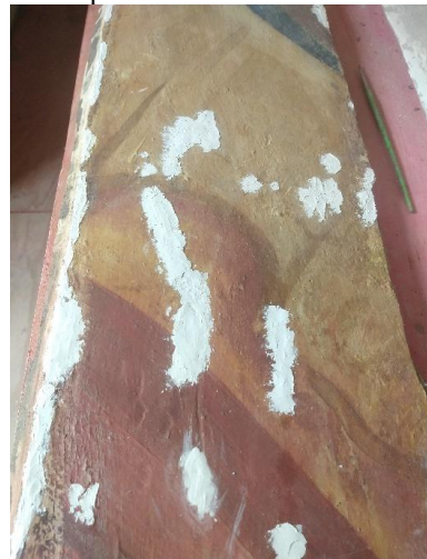
Figura 54 - Detalhe de nivelamento remoção de repintura do forro da nave
