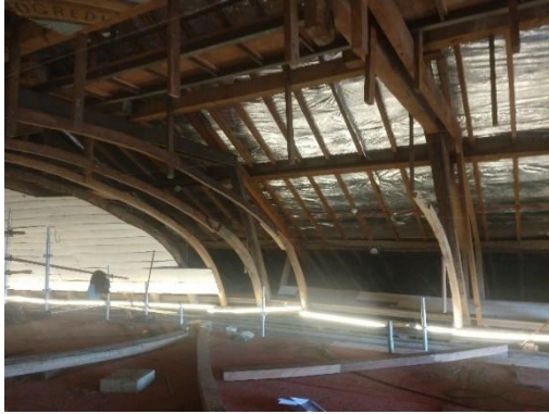
Figura 29: Alinhamento e prumo para substituição de cambotas do quarto quadrante.
