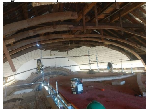
Figura 24 - Introdução de novas peças de cambotas seguindo o novo prumo do terceiro quadrante.
