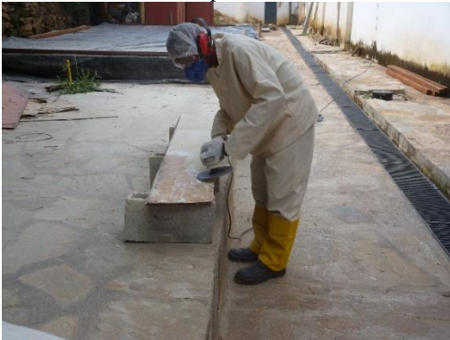
Figura 41 - Lixamento das pinturas lisas do forro da nave.
