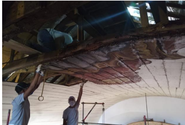
Figura 18 - Processo final de desmonte das tábuas do forro da nave.
