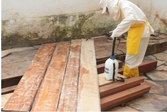
Figura 43 - Aplicação de cupinicida na parte posterior das tábuas lixadas.
