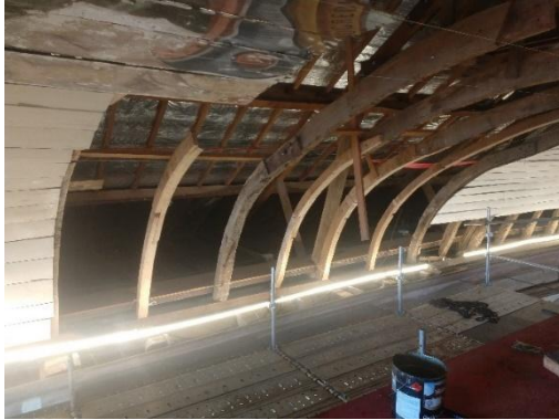
Figura 25 - Vista parcial da instalação das novas peças de cambotas.
