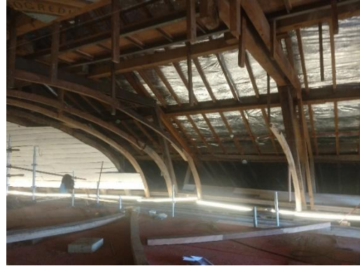
Figura 26 - Inserção/troca de novas peças de cambotas.
