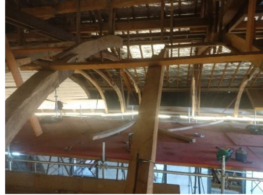
Figura 30: Inserção réguas para alinhar as peças de cambotas.
