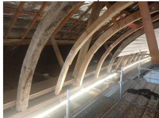
Figura 28 - Detalhe peças de cambotas, com novo alinhamento “pés”
