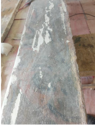
Figura 51 - Detalhe de nivelamento nas tábuas centrais do forro da nave
