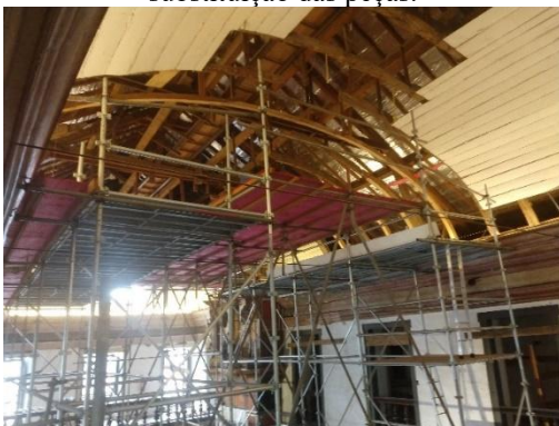
Figura 23 - Vista da estrutura montada para substituição das peças.
