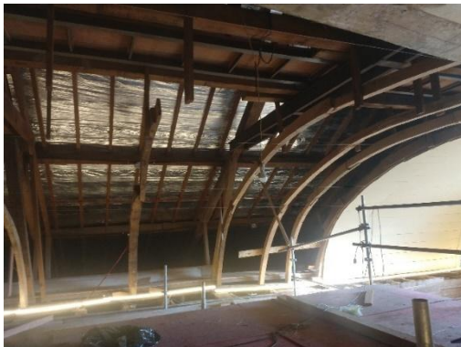
Figura 27 - Inserção/troca de novas peças de cambotas.
