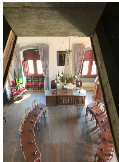
Figura 12: Janela aberta para o operador de som e transmissão, projetada para ser removível no forro, garantindo mínima intervenção e preservação do objeto histórico. Fotografia do autor.
