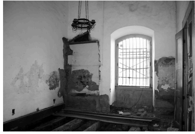
Figura 30: Exame detalhado das vigas estruturais de madeira da Câmara Municipal de Mariana, evidenciando sua configuração e integridade estrutural. Fotografia de autoria do pesquisador.
