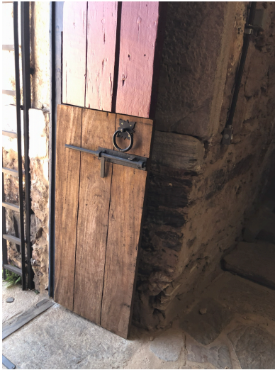
Figura 5: O processo de reversibilidade foi realizado na porta dos fundos, que anteriormente era uma janela, possibilitando sua futura reversão. Fotografia do autor.
