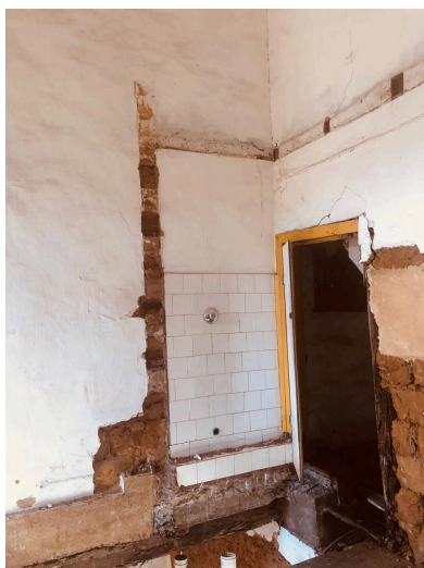
Figura 15: Banheiro em processo de ampliação, destacando a estrutura antiga na restauração realizada pela empresa A3. Registro de Adriano Furini
