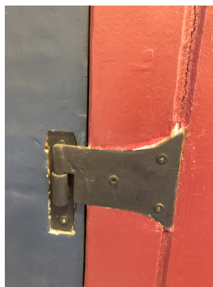
Figura 2: Portas e esquadrias pintadas na cor identificada por meio de prospecções anteriormente empregadas. Fotografia da autor.
