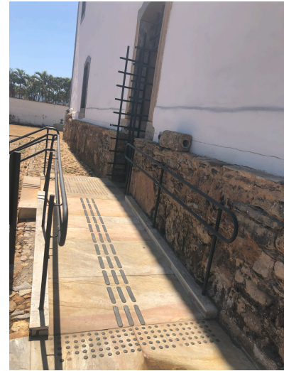
Figura 7: Reversibilidade realizada na porta dos fundos, antes uma janela, permitindo futura reversão (vista externa). Fotografia do autor.
