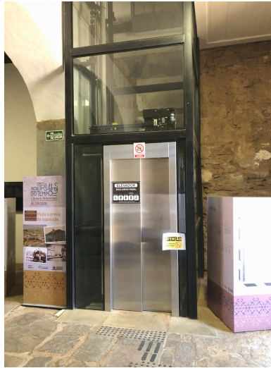
Figura 6: Um elevador foi acrescentado, porém o processo é reversível caso seja necessário. Fotografia do autor.
