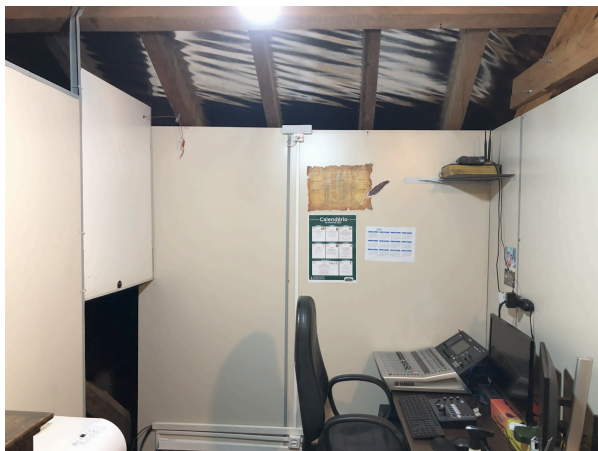
Figura 13: Escritório no sótão, construído com divisórias industriais, projetado para transmissões online e som das reuniões no plenário, preservando a estrutura histórica. Fotografia do autor.
