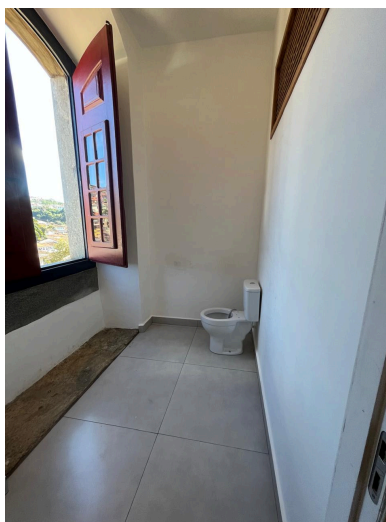
Figura 16: Banheiro masculino em finalização, com instalação do vaso sanitário na reforma realizada pela empresa A3. Registro de Adriano Furini.
