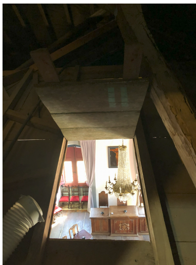
Figura 11: Janela aberta para o operador de som e transmissão, projetada para ser removível. Fotografia do autor.
