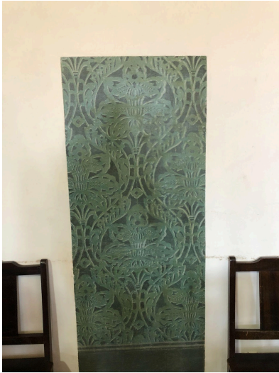
Figura 3: Alvenarias pintadas com tonalidades e artes identificadas por prospecções, conforme uso anterior. Fotografia do autor.
