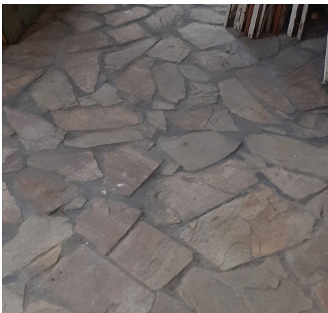
Figura 27: Preservação do piso em estrutura de pedra na restauração executada pela empresa A3 no CAC, com registro de Adriano Furini.
