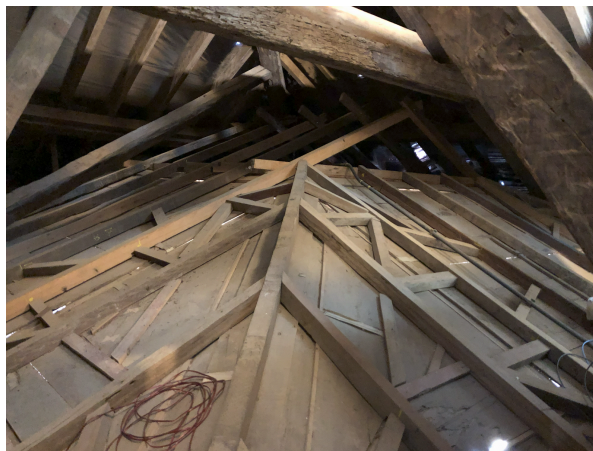
Figura 14: Estrutura do telhado e do forro do plenário. Fotografia do autor.
