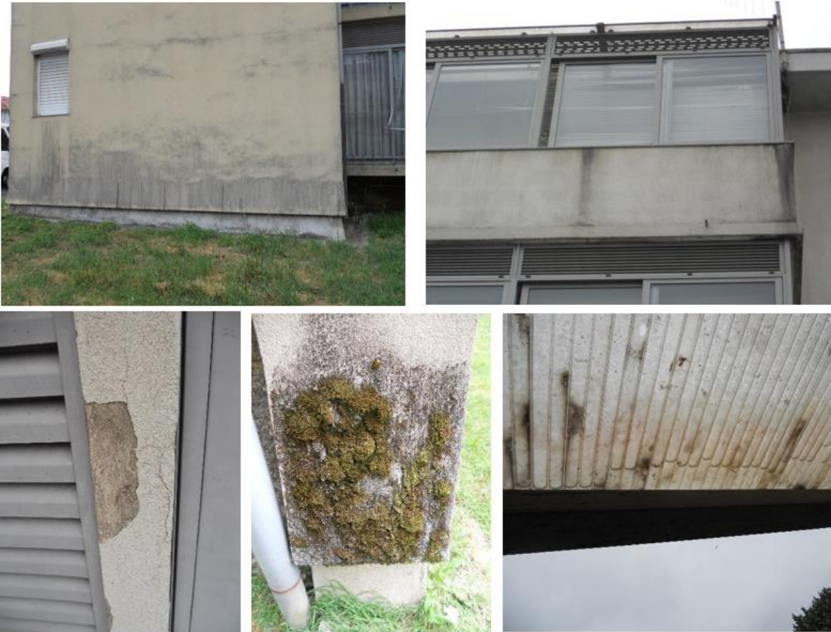
Figura 5 – Manifestações patológicas no envolvente exterior do edifício em Porto
